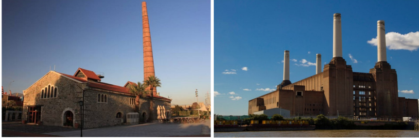
Şekil 6. İzmir Tarihi Havagazı Fabrikası (solda) ve Battersea Enerji Santrali (sağda)
