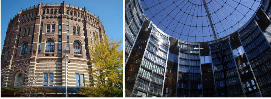
Şekil 8. Viyana Gazometreleri'nin iç ve dış cephelerinden görünümüler
