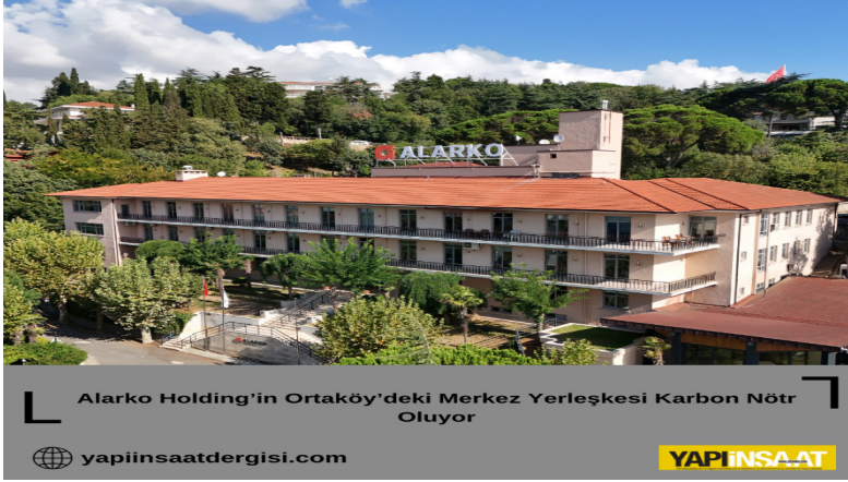
Şekil 7. Alarko Holding Merkez Yerleşkesi [21]
