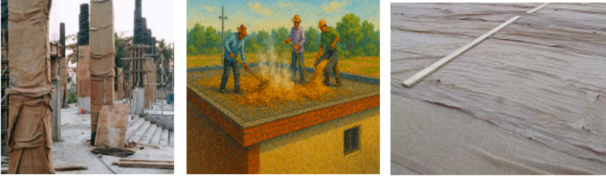
Şekil 7. Islak kaplamalı kürleme
