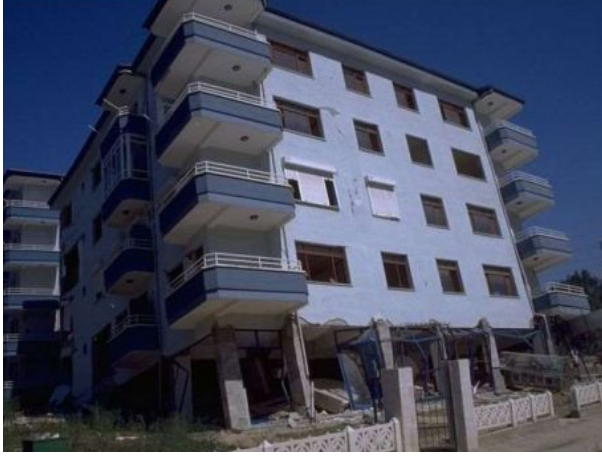
Şekil 1. Yumuşak kat oluşumunu gösteren bina örneği (Url-1).
