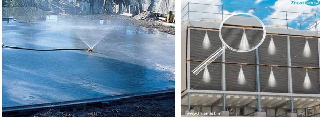
Şekil 2. Yağmurlama/püskürtme kürleme tekniği
