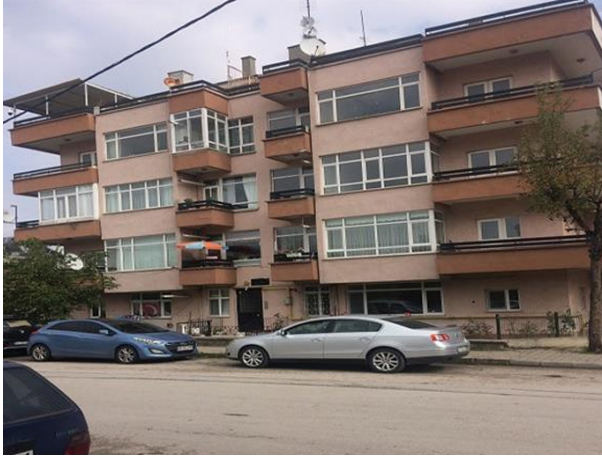
Şekil 2. Ağır çıkma oluşumunu gösteren bina örneği.
