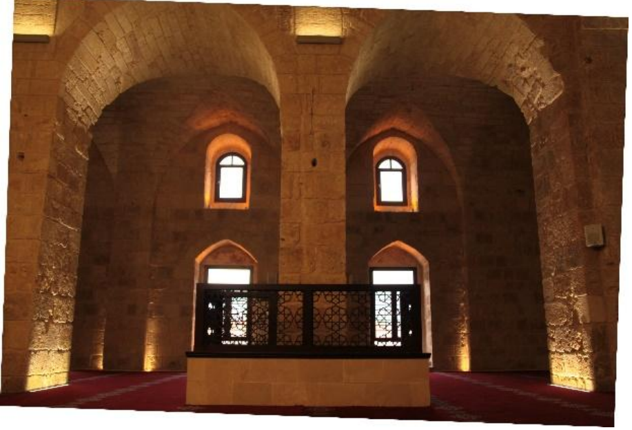
Şekil 11 Taş kolon aydınlatma örneği
