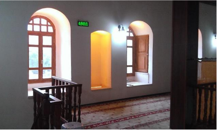
Şekil 12 Niş aydınlatma örneği
