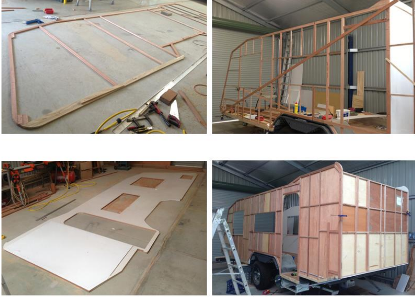
Şekil 9. Karavan duvar yapımının dört aşaması
