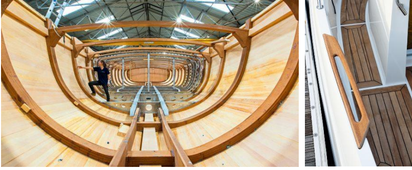
Şekil 7. Yat yapım süreci ve zemin kaplaması
