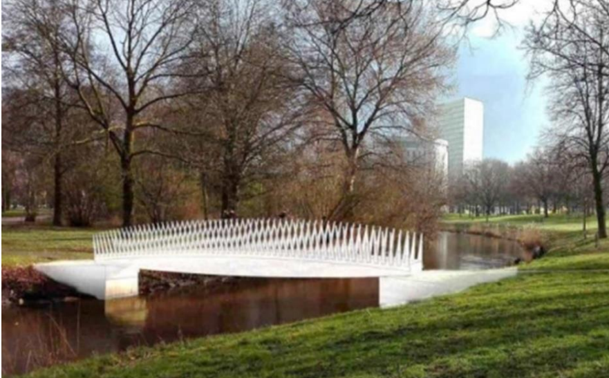
Şekil 1. Doğal elyaf takviyeli polimer kompozitten yapılmış yaya köprüsü (Leplaar vd., 2016).
