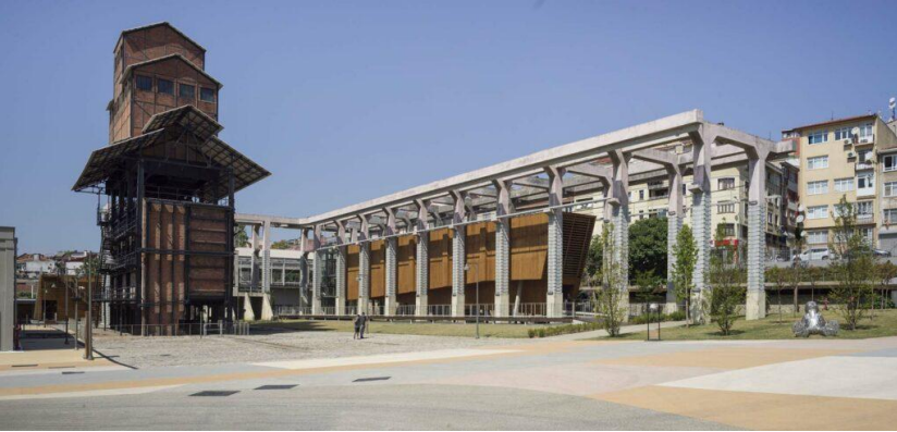
Şekil 3.7 Hasanpaşa Gazhanesi Restorasyonu, İstanbul
