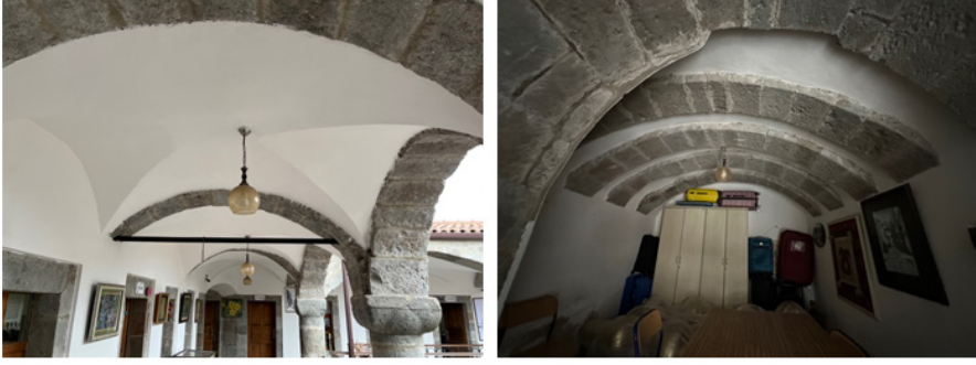
Resim 6. Revakların çapraz tonoz üst örtüsü (solda) ile odaların kemerlerle desteklenen beşik tonoz örtüsünden (sağda) görünüm (Engin, 2023).
