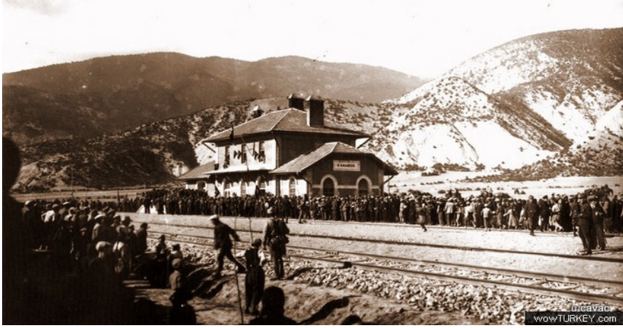
Şekil 2. Karabük Tren İstasyonu (Karabük Belediyesi Arşivi).
