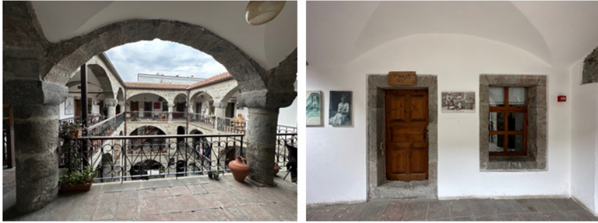
Resim 7. Revakların tonoz üst örtüsünü taşıyan kesme taş destek kemerleri ve taş sütunları (solda) ile odaların revaklara açılan taş söveli kapı ve pencerelerinden (sağda) görünüm (Engin, 2023).
