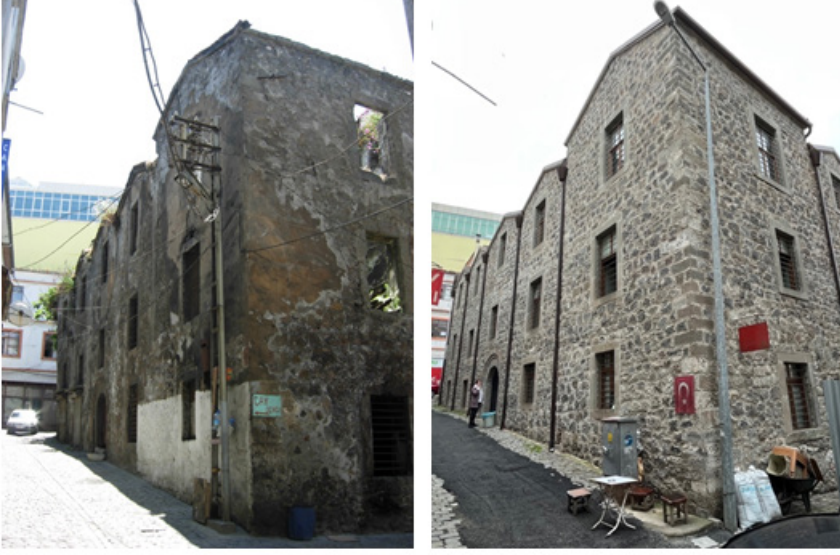
Resim 13. Alaca Han'ın siva raspaşı yapılarak temizlenen cephesinin restorasyondan önceki (solda) ve sonraki (sağda) halinden görünümüleri (Engin, 2023).
