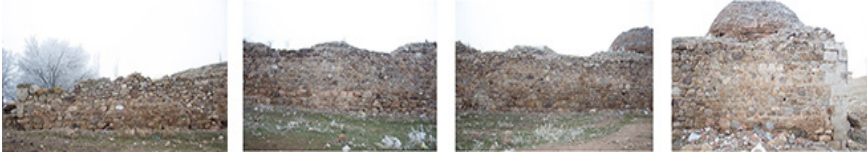
Şekil 55. Soldan sağa doğru; ahır odası (pastane) doğu cephe dış duvarının görünüşü, 5 ve 6 numaralı konaklama odalarının doğu cephe dış duvarının görünüşü, konaklama odaları doğu cephe dış duvar görünüşü ile 1 numaralı odanın doğu cephe dış duvarı görünüşü
