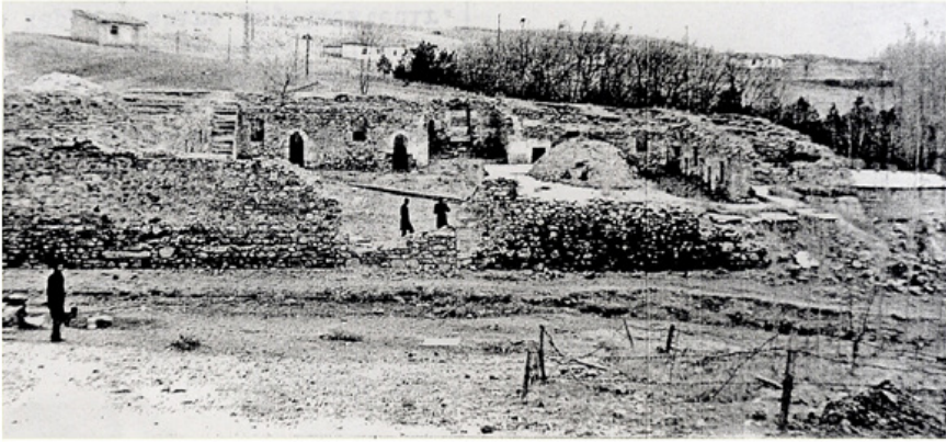
Şekil 23. Kuzey cepheden 1982 yılında çekilmiş yapının ılıca odası ve 1 numaralı konaklama odasının üzerindeki kubbeler ile Selçuklu dönemi esas girişin konturlarını gösteren fotoğraf (Vakıflar Genel Müdürlüğü arşivi)
