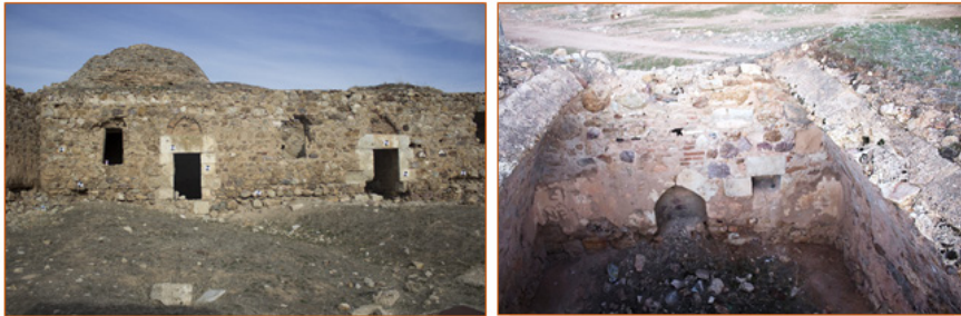
Şekil 20. 1 numaralı odanın kubbesi ile diğer odaların tonoz üst örtüsünün kırıлма hizasındaki kalıntılarının görünüşü
