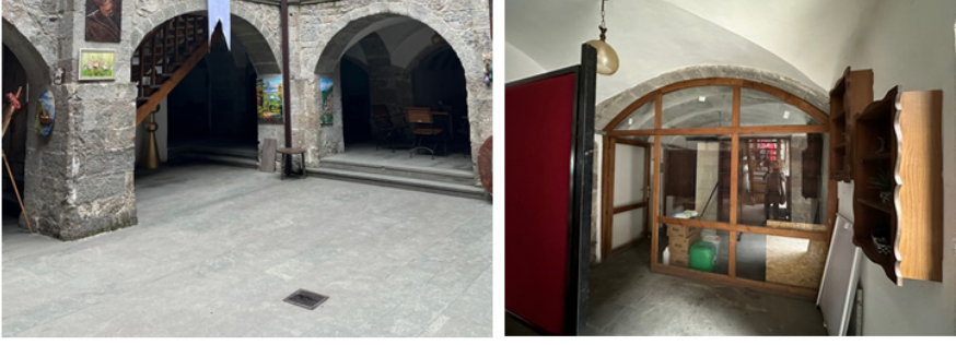
Resim 15. Alaca Han'ın avlusunun yenilenen kesme taş döşemesi (solda) ile zemin katta bulunan deponun revaklarla bağlantısını sağlayan kemerli açıklığa eklenen yeni bölücü (Engin, 2023).
