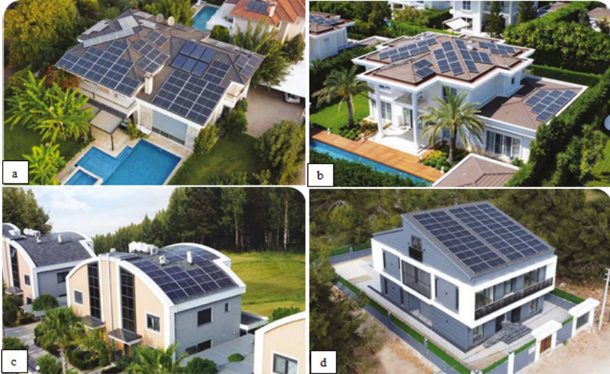
Şekil 6. PV panel kullanılan örnekler (Enerjievi, bt.)
