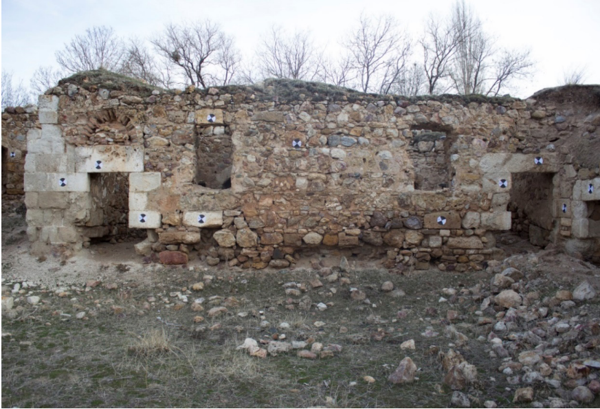
Şekil 1. Referans taşları üzerine yapıştırılan numaralandırılmış fotogrametrik artıların görünüşü
