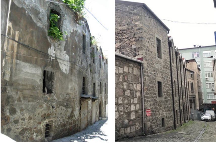
Resim 11. Alaca Han'ın yıkılmak üzere olduğu için sökülerek yeniden inşa edilen doğu cephesinin restorasyondan önceki (solda) ve sonraki (sağda) görünümüleri (Engin, 2023).
