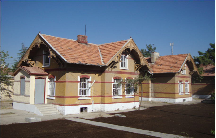
Şekil 5. Konya İstasyon Lojmanlarından Bir Görünüm (Karakul, 2017).
