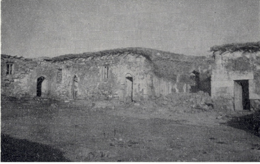
Şekil 22. Karakurt'un eyvan ve oda girişlerini gösteren güney cephesi ile doğu cephesinde çatıya çıkan merdiven ve altında 5 numaralı odaya giren kemerli girişin görünüşü (Eyice, 1971;254).
