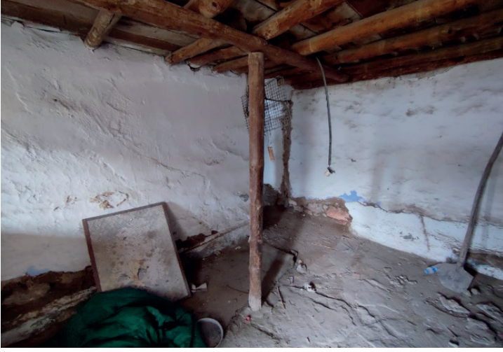
řekil 9. Zemin Kat İ Mekan Görünüş (Özel arřiv)
