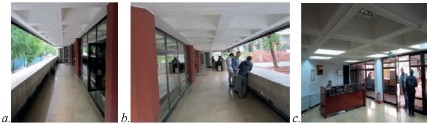
Şekil 5. a. 1 no.lu mekan güney cephesi, b. 1 no.lu mekan doğu cephesi c. 2 no.lu mekanın doğu cephesi
