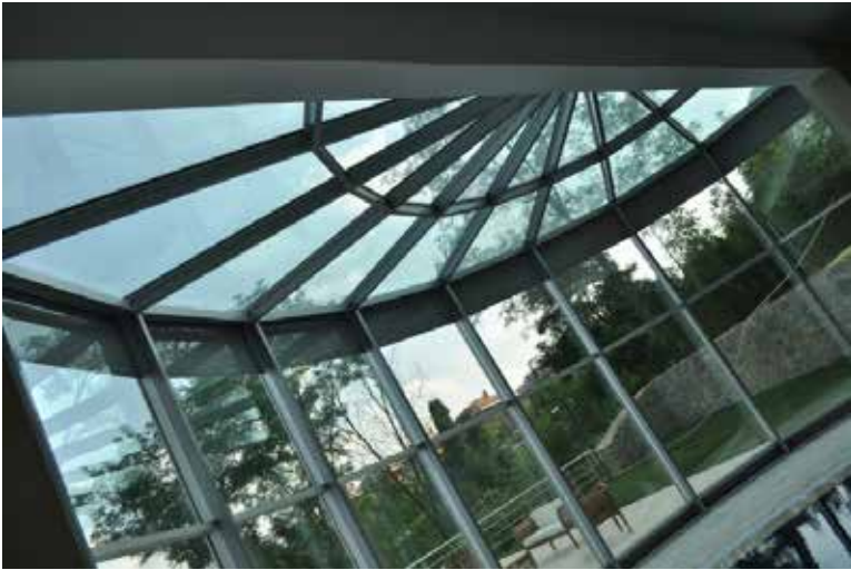
Figure 2. An aluminum skylight example (Elips Yapı) (URL-2)
