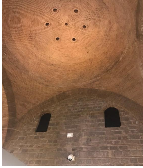
Görsel 2: Kurşunlu Han'ın yapılan restorasyon çalışmalarında açıklık ve vitrayları kapatılmıştır. Kaynak: Soufi Moazemi Arşivi
