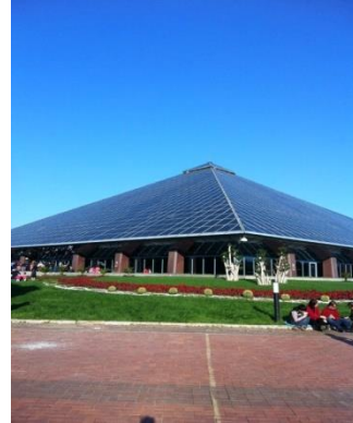
b. Yapının güncel görünümü (URL-4, 2019)
