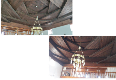
Şekil 4. Kırangıç tavan örneği
