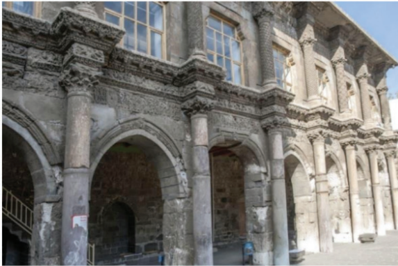
Resim 1: 11. Yüzyıl, Diyarbakır Ulu Camii, Büyük Selçuklu Hükümdarı Melikşah Dönemi, Diyarbakır (Özsoy, 2021, s. 19).
