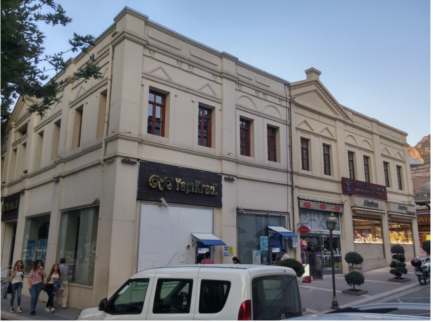
Resim-1: Binanın genel görünümü
