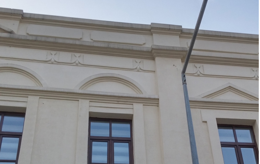
Resim-10: Binanın saçak kornişleri
