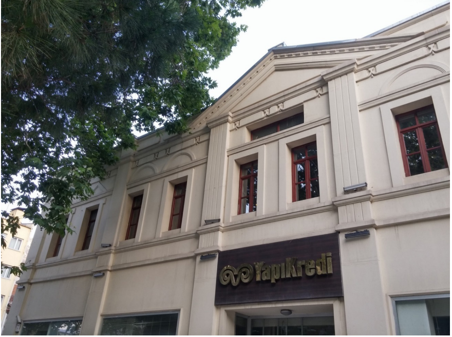
Resim-5-6: Batı cephesi pencere üstlerindeki süslemeler
