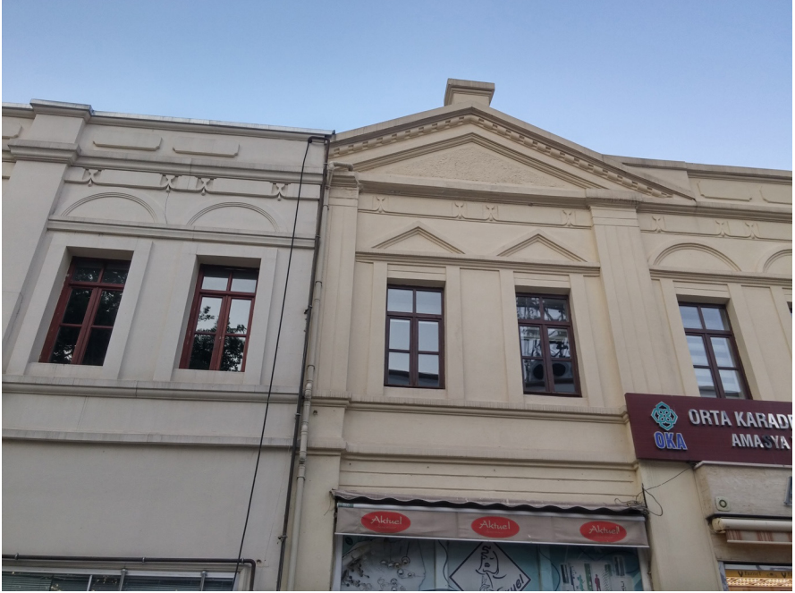
Resim-3: Binanın güney cephesindeki plastrlar
