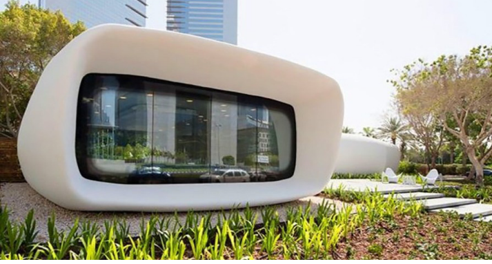
Şekil 7. Tamamen 3D yazıcılar ile üretilmiş Ofis binaları [22]
