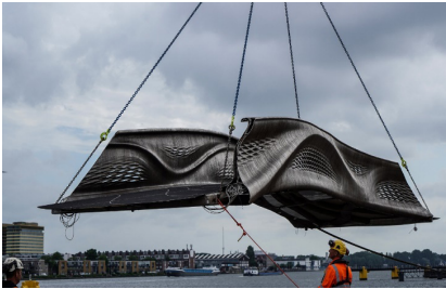
Şekil 6. 3D yazıcı ile yapılan ilk çelik köprü [21].
