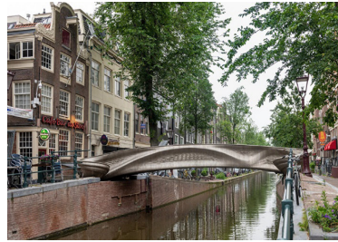
Şekil 6. 3D yazıcı ile yapılan ilk çelik köprü [21].
