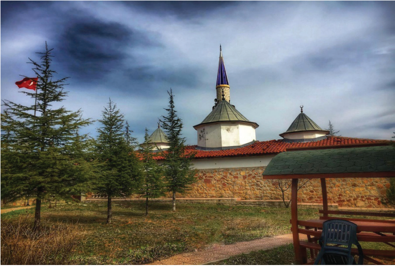
Resim 6 Bacım Sultan Türbesi dış mekan)
