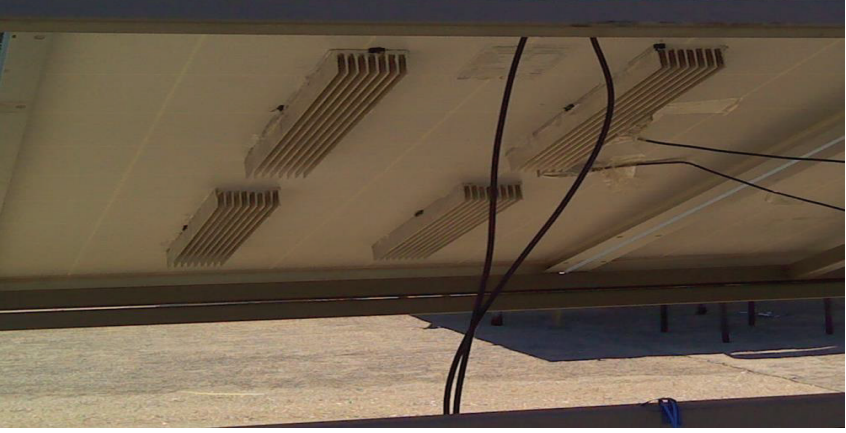
Şekil 5: Fotovoltaik Panel Alt Yüzeyine Pasif Soğutucu Uygulaması
