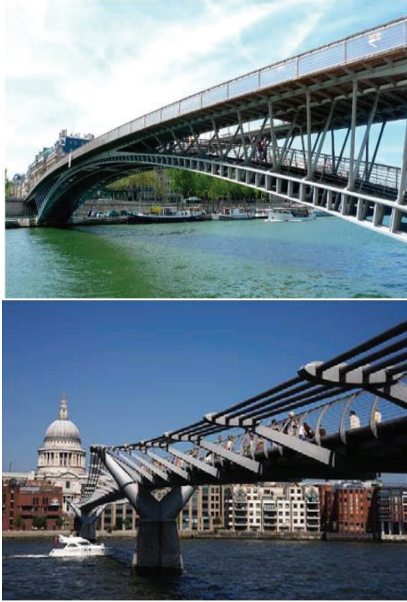
Şekil 1: Solferino Köprüsü (solda) ve Millenium Köprüsü(sağda) (Altememy, 2015)
