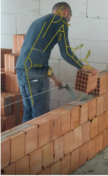
Resim 5: Tuğla örme görevi orta seviye çalışma pozisyonu ve REBA analizi skoru
