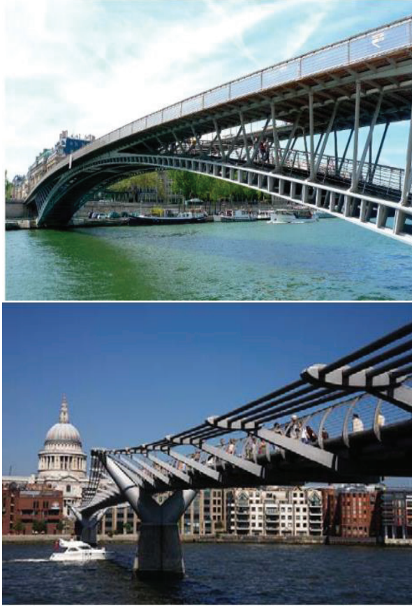
Şekil 1: Solferino Köprüsü (solda) ve Millenium Köprüsü(sağda) (Altememy, 2015)
