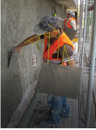
Resim 8: Sıva yapma görevi orta seviye çalışma pozisyonu ve REBA analizi skoru
