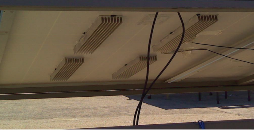
Şekil 5: Fotovoltaik Panel Alt Yüzeyine Pasif Soğutucu Uygulaması
