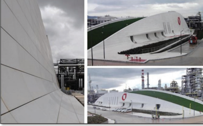
Şekil 3: Kendi kendini temizleyen çimento ile üretilmiş cephe kaplaması örneği [13].
