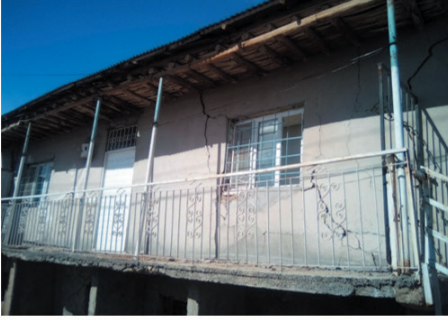
Şekil 19. Farklı zemin oturmalarına bağlı yapısal hasarlar
