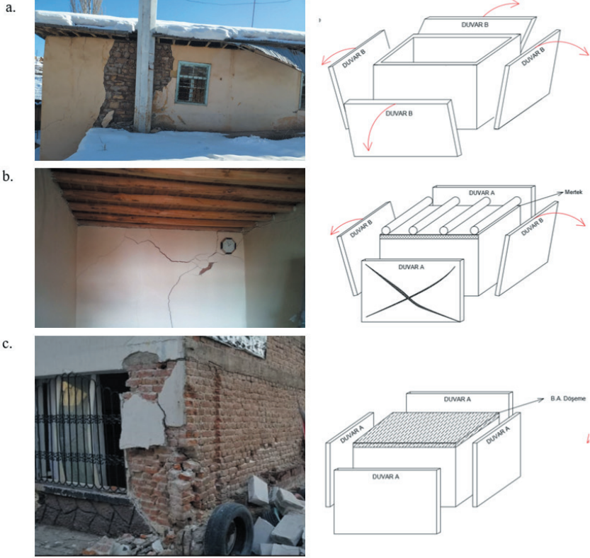
Şekil 26. Yığma duvarlarda döşeme türüne bağlı düzlem içi/dışı göçme modelleri (a) döşemesiz (b) mertekli (c) betonarme döşemeli (Akgül ve Doğan, 2020)
