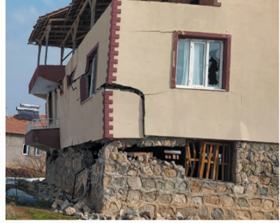
Şekil 19. Farklı zemin oturmalarına bağlı yapısal hasarlar
