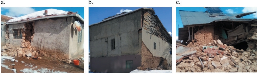
Şekil 17. Malzeme özelliklerine bağlı yapısal hasarlar
