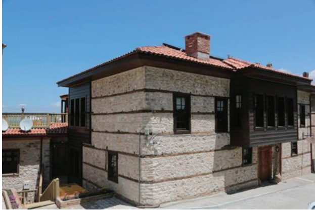
Şekil 7 Restorasyon öncesi ve Şekil 8 Restorasyon sonrası (Kaynak: H.Haştemoğlu Arşivi)
