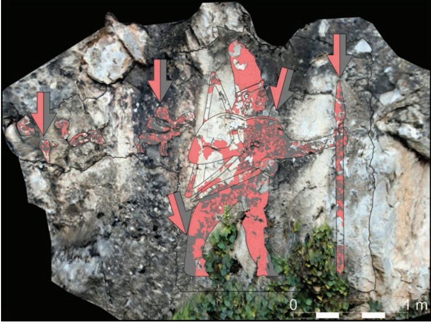
Figür 7. Yüzey sularının kanalize olduğu hatlarda, granüler ayrışma tipi bozunma ve siyah renkli yosun kolonileri.
