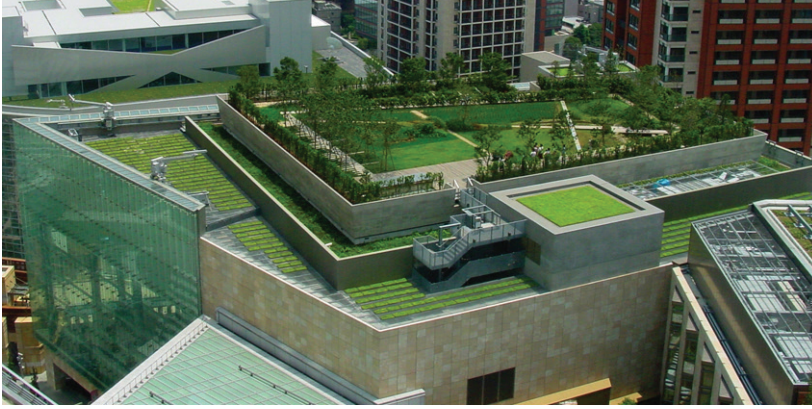
Şekil 9 . Yeşil çatı uygulama örneđi (URL-1)
