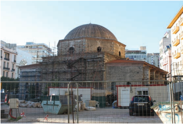
Şekil 12. Hamza Bey Caminin restorasyon çalışmasındaki hali (Umar, 2012)
