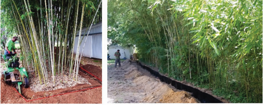
Şekil 28. Kapalı bariyer oluşturulması (URL-30 ve 31, 2019)
