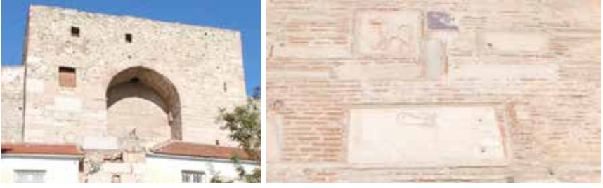
Şekil 5. Yedi Kule Kalesi giriş burcu ve devşirme malzemelerin görünümü ile giriş burcunun üzerindeki Sungur Çavuş Bey kitabesi (Umar, 2012)
