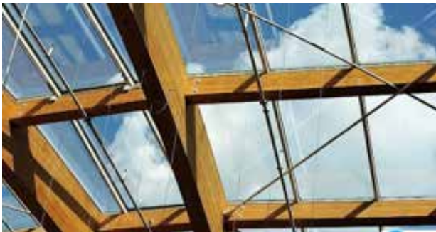
Şekil 4. Glulam (santiyede.com/). Laminasyon işlemi ile mukavemet kazandırılmış özel ahşaplar
