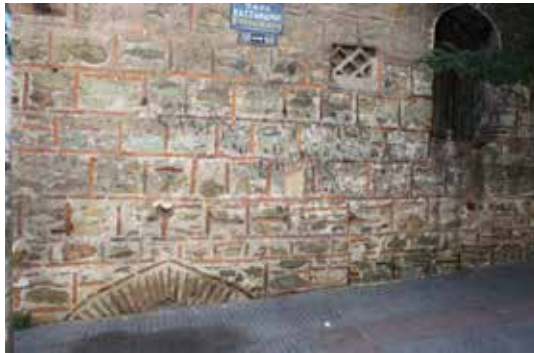
Şekil 23. Yeni Hamam bloke olan pencerelerin görünümü (Umar, 2012)
