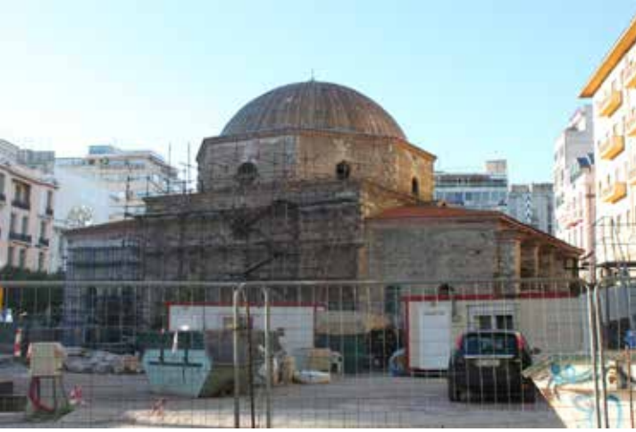
Şekil 12. Hamza Bey Caminin restorasyon çalışmasındaki hali (Umar, 2012)
