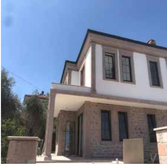
Şekil 7: Bina Taş duvar Kaplama (Orijinal, 2019)
