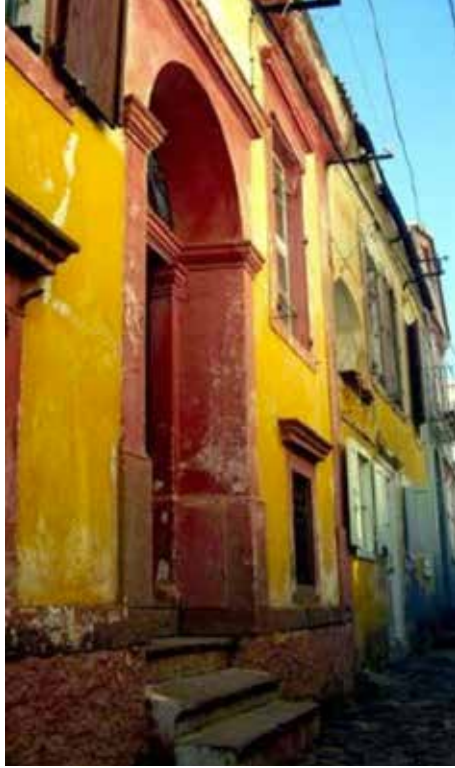
Şekil 3: Sarımsak Taşı kullanılmış bir ev cephesi (Asimgil ve Erdoğan, 2013)
