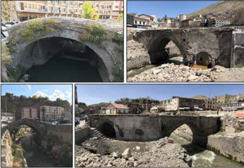
Şekil 15. Bitlis kent merkezinde yer alan köprüler
