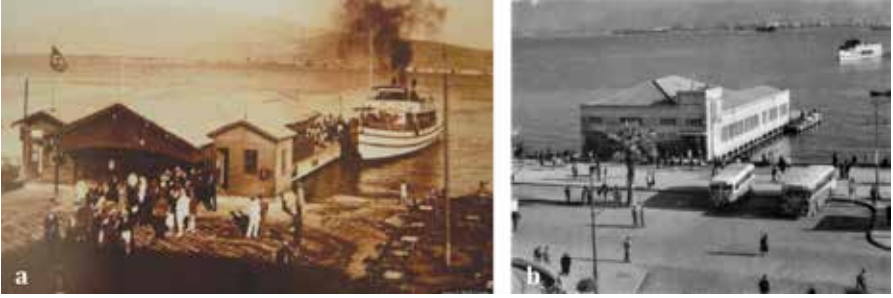
Şekil 9. a. Karşıyaka ilk ahşap iskele; b. Karşıyaka ilk betonarme iskele (Özsoy, 2009).
