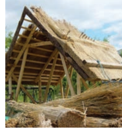
Şekil 12: Saman veya sazlık ile oluşturulan bambu çatı kaplaması a: (López, 2003), b: (URL-7).
