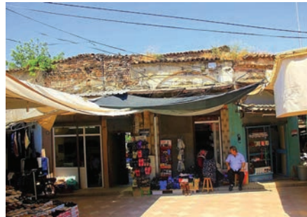
Şekil 3. Çöplüce Han Cephe (URL-1)
