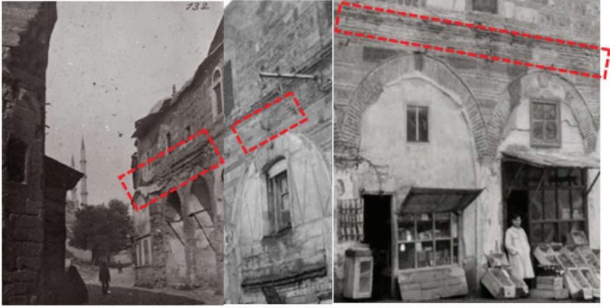
Şekil 15: Kervansaray'ın dükkânları- kemer üzerinde yer alan saçak ve L-lama demir izleri (URL-6)
