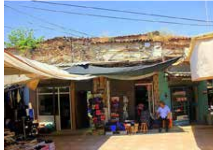
Şekil 3. Çöplüce Han Cephe (URL-1)
