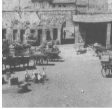
Şekil 7. Cephe Görünüşü (Özkarci, 1998)
