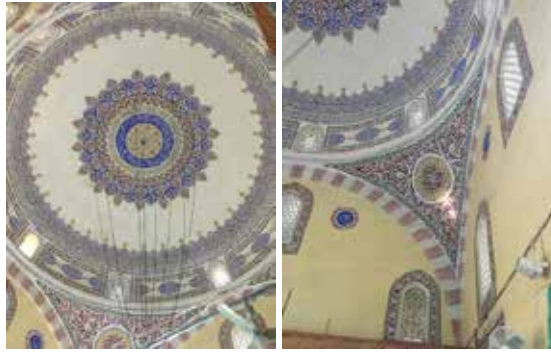
Şekil 7. Lala Paşa Cami'nin kubbe üst örtüsü ve pandantif elemanı
