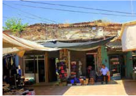
Şekil 3. Çöplüce Han Cephe (URL-1)
