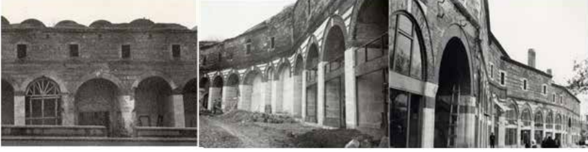
Şekil 19: Kervansaray'ın 1960'larda yapılan restorasyon çalışmaları, öncesi ve sonrası
