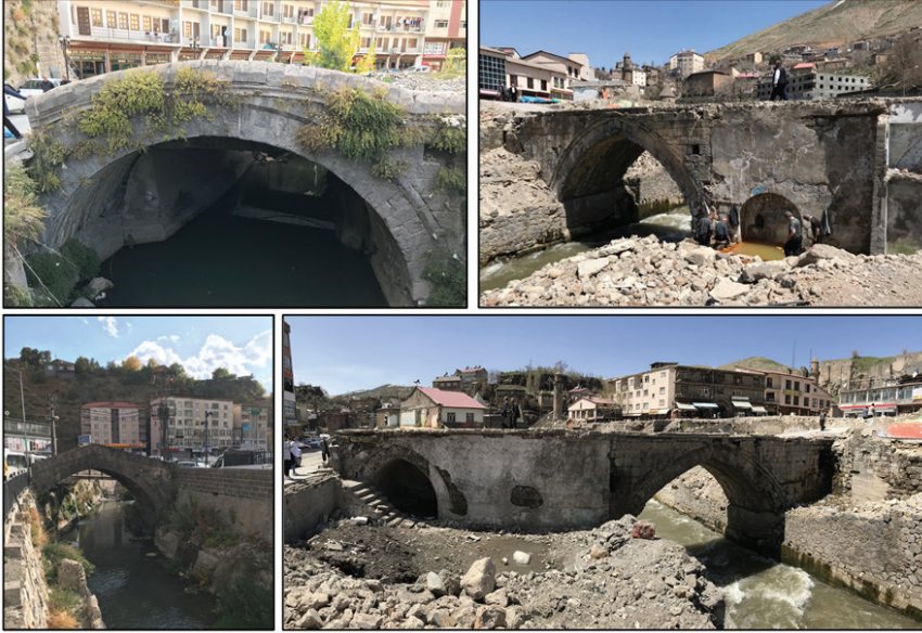
Şekil 15. Bitlis kent merkezinde yer alan köprüler
