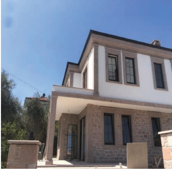
Şekil 7: Bina Taş duvar Kaplama (Orijinal, 2019)
