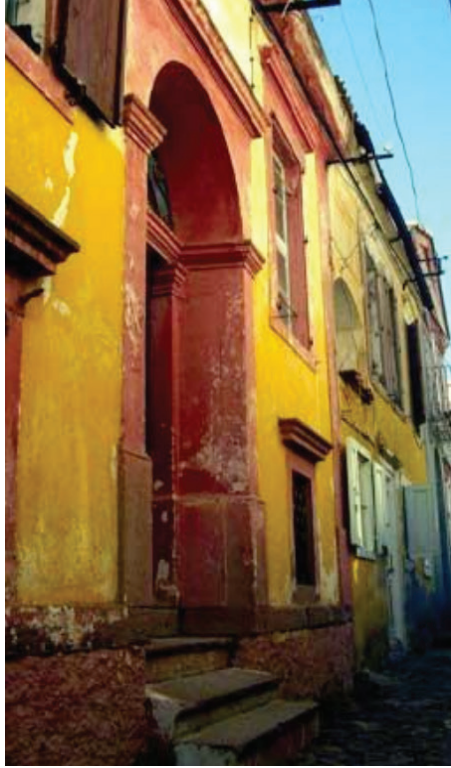
Şekil 3: Sarımsak Taşı kullanılmış bir ev cephesi (Asimgil ve Erdoğan, 2013)
