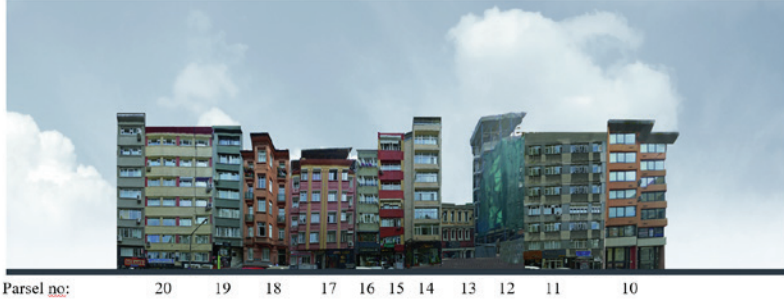
Şekil 8: Abide-i Hürriyet Caddesi parsel 10-20 arası mevcut görünüş
