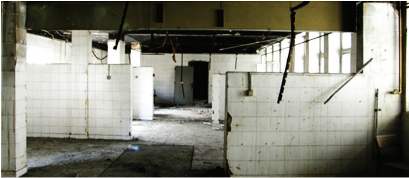
Şekil 8. PTT Pul Müzesi İç Mekân Restorasyon Öncesi Zemin Kat ( www.vitracagdasmimarlikdizisi.com )
