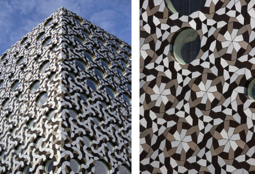
Resim 10: Ravensbourne Koleji'nin Çini Karo Cephe Uygulaması (Url 4)
