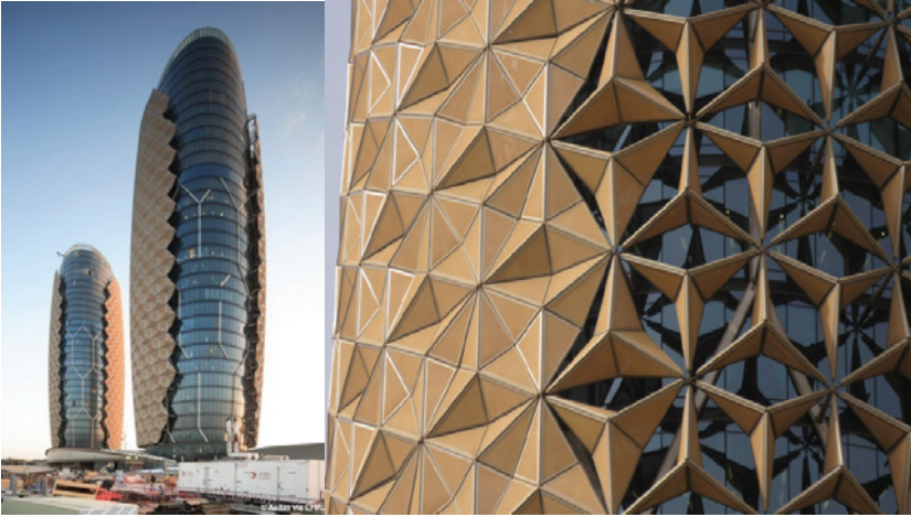
Resim 15: Al Bahar Kuleleri'nin cephesindeki hareketli geometrik sistemin görüntüsü(Url 10)
