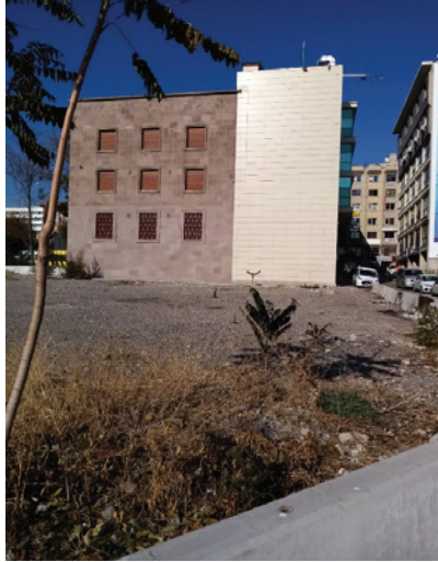
Şekil 10. Yapının Arkasında Bulunan Ek (Ünsalar, 2020)
