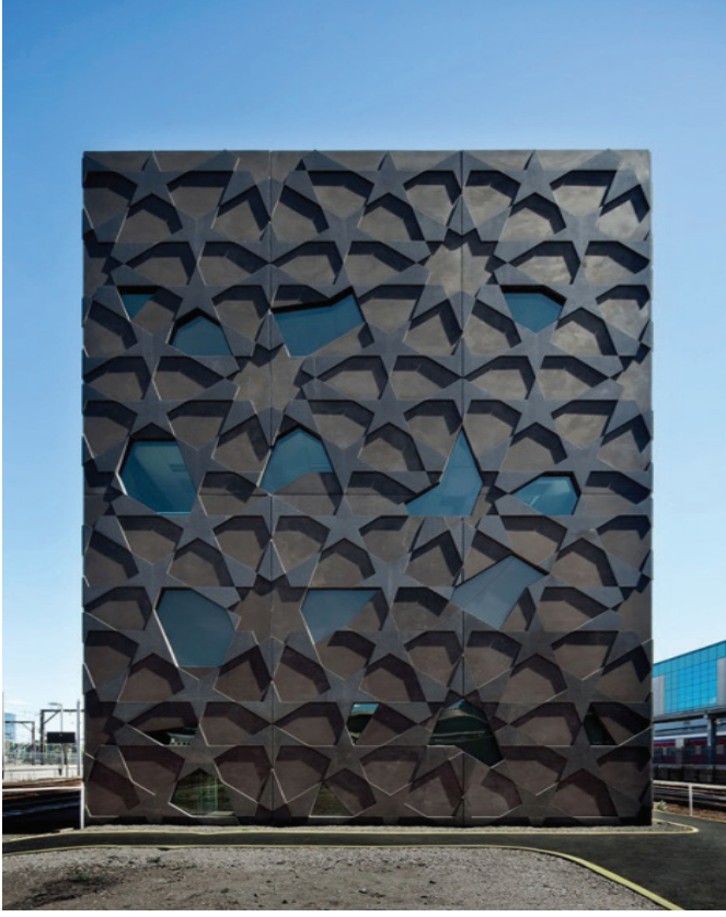
Resim 12 : Yardmaster Binası'nın cephe görünüşü (Url 6)
