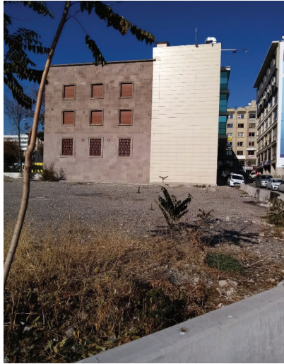
Şekil 10. Yapının Arkasında Bulunan Ek (Ünsalar, 2020)
