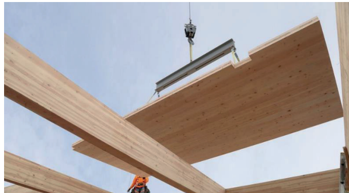
Şekil 3. CLT döşeme paneli (URL-8).
