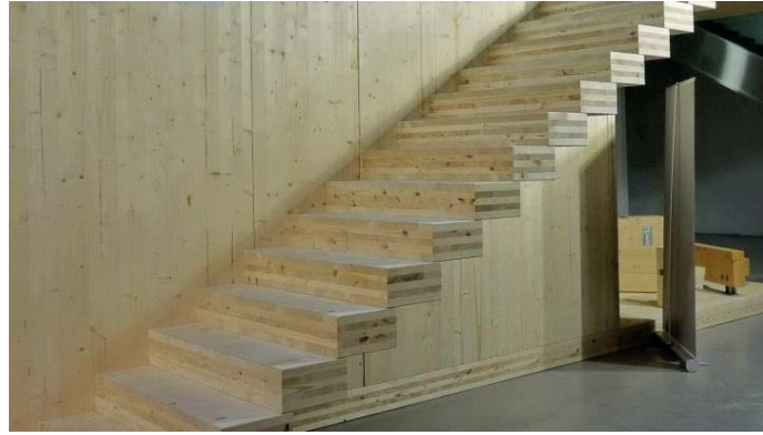
řekil 5. CLT merdiven uygulaması (URL-10)
