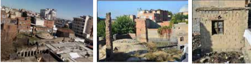
Şekil 25. Deva Hamamı üstünde toprak dolgu ve niteliksiz ekler
