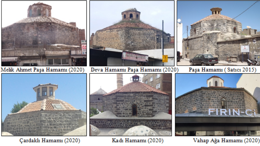
Şekil 3.Diyarbakır Suriçi Bölgesindeki Hamam Örnekleri
