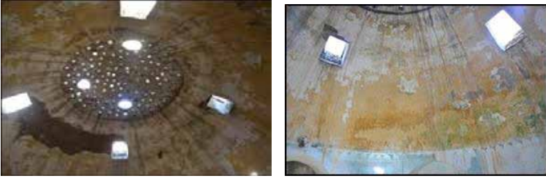
Şekil 28. Sıcaklık kubbesindeki fil gözleri ile pencereler
