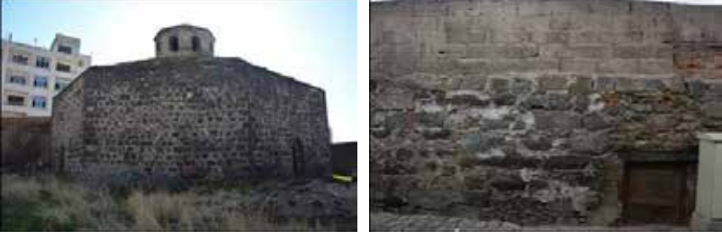
Şekil 22. Soğukluk kubbe çevre duvarı - kuzey cephe duvarı
