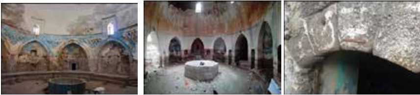
Şekil 26. Soğukluk ve sıcaklık bölümlerindeki kemer ve tonozlar
