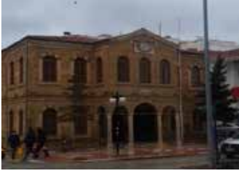
Askerlik Şubesi Binası
