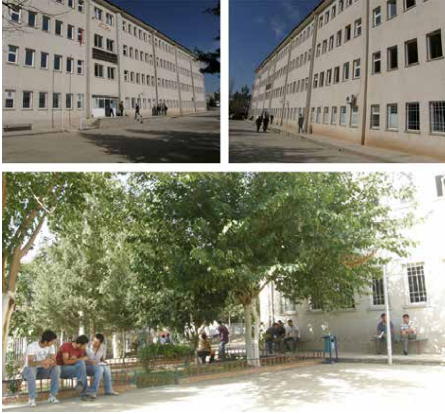
Şekil 2. Çalışma alanının sert zeminle kaplı giriş ve otopark kısmının uygulama öncesi durumu
