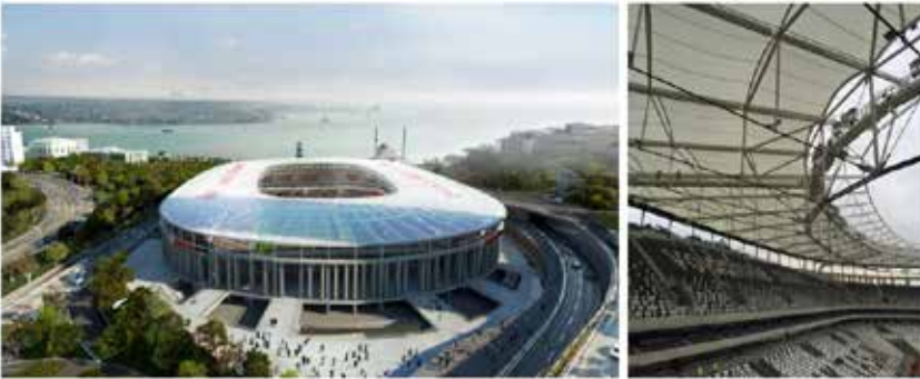
Şekil 3. 2 Vodafone Arena örtü sisteminde PTFE malzeme kullanımı (Url-3)
