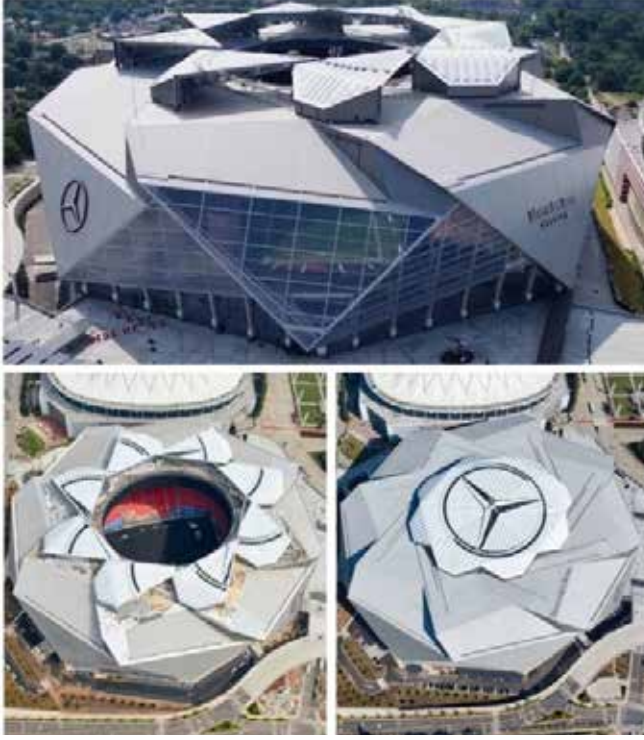
Şekil 5. 3 Stadyum çatısının açık ve kapalı hali (Url-15)
