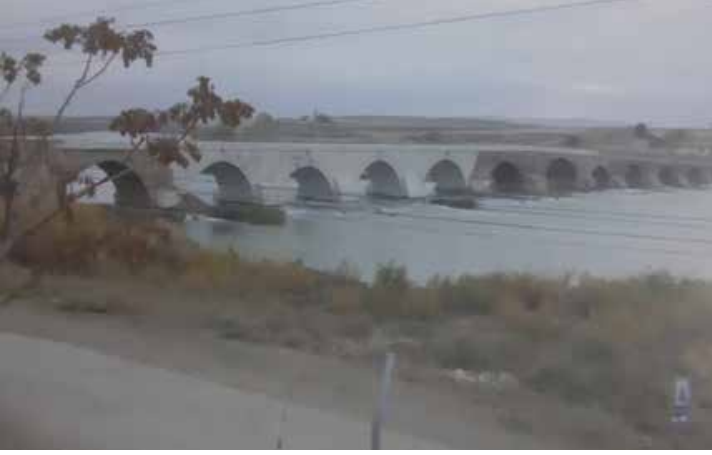
Şekil 7: Kırşehir'in merkez ilçesinde yer alan ulaşım yapısı Kesikköprü (Güçlü, 2006:43)
