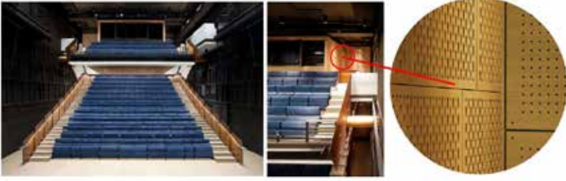
Şekil 17. Jerome Robbins Theatre, Baryshnikov Arts Center, New York (WASA, Studio A, Arup) seyirci arka kısmında boşluklu rezonatör kullanımı (Patel, 2020; Url-3)
