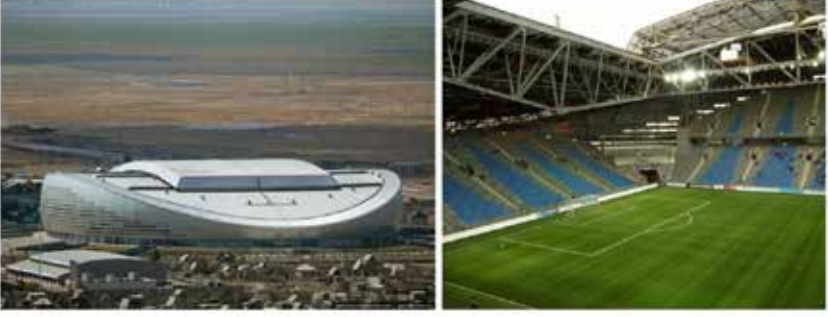
Şekil 4.1 Hareket eden çelik malzeme çatı-Astana Stadyumu 2009 (Url-9)
