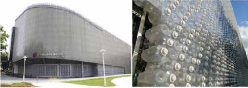
Şekil 3. 5 Cephesi plastik şişeden oluşan EcoArk projesi (Url-6)
