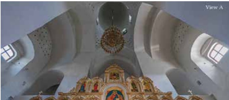
Şekil 12. Theophany Kilisesi, Pskov boşluklu rezonatör kullanımı (Kanev, 2020)
