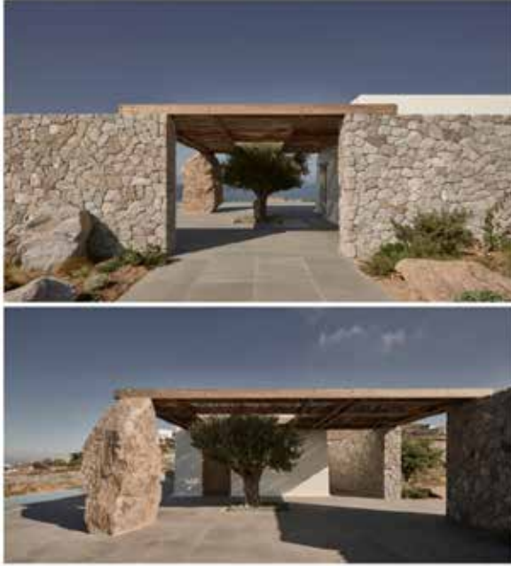
Şekil 3. 8 Cephede kaplama taş malzeme kullanımı (Url 8)
