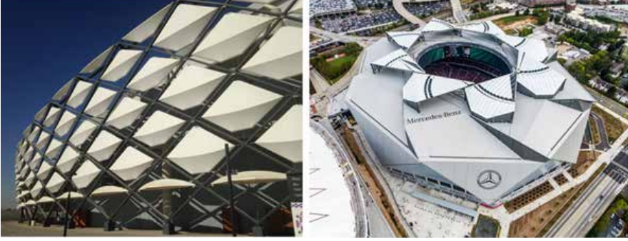
Şekil 2. 2 Hazza Bin Zayed Stadyumu hareketli cephesi ve Mercedes Benz Stadyumu hareketli üst örtüsü ( Url 2)
