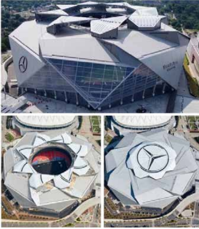
Şekil 5. 3 Stadyum çatısının açık ve kapalı hali (Url-15)
