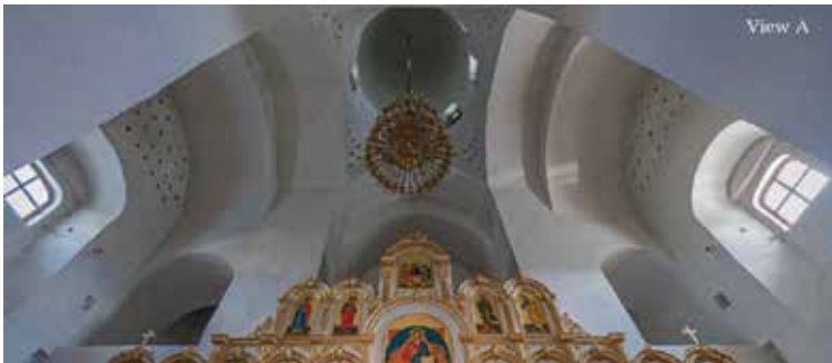
Şekil 12. Theophany Kilisesi, Pskov boşluklu rezonatör kullanımı (Kanev, 2020)
