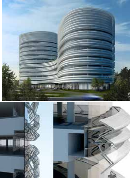
Şekil 31. CJ Blossom Park (solda), PTFE Gölgeleme Sistemi Detayı (sağda) [Url-10]
