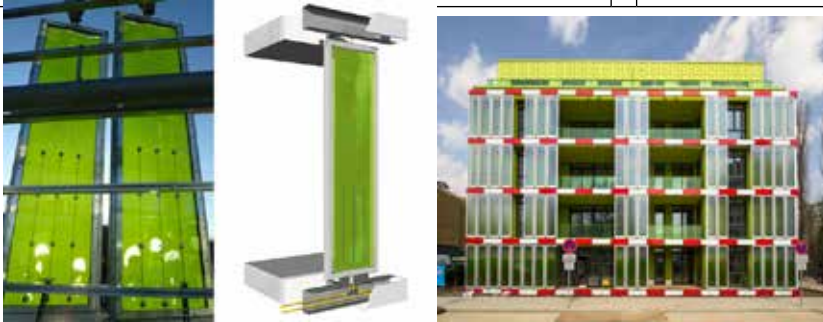
Şekil 27. Biyoreaktör Cepheli Bina(Solda), Gölgeleme Paneli Detayı(Sağda) [Url-7]
