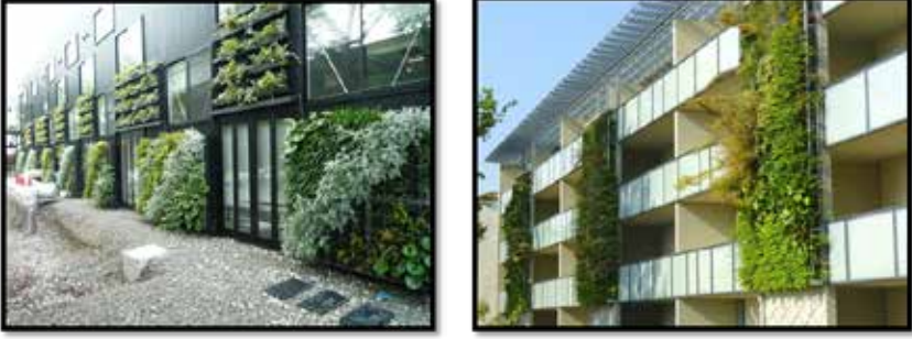
Şekil 8 Yaşayan Duvar/Biyo Duvar Sistemleri (URL, 2021c)
