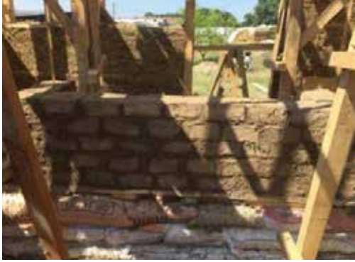
Resim 2.1. Kerpiç blok yığma duvar kerpiç (Url-2)
