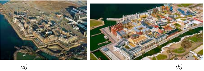
Şekil 2. Bo01 inşaat süreci ve sonrası havadan görünüm (a) (Kuitenbrouwer, 2014), (b)
