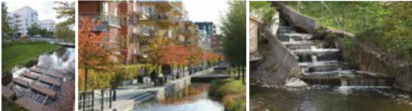
Şekil 26. Hammarby Sjöstad'daki yağmur suyunun tutulduğu çeşitli bölgeler(su hendeği, havuzu, merdiveni) (Foletta & Field, 2011).
