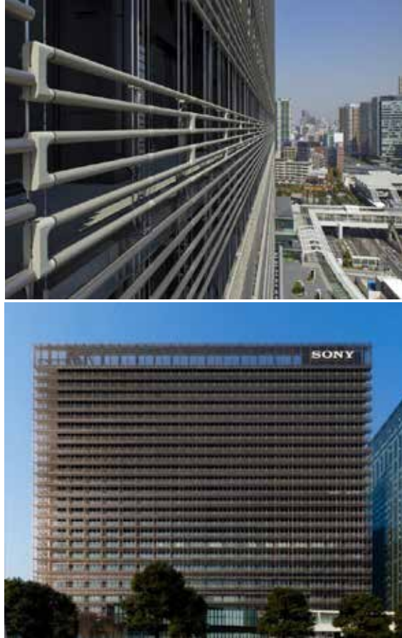
Şekil 35. Sony City Osaki-Bioskin Cephe Detayı [48]
