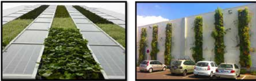
Şekil 7 Yaşayan Duvar/Biyo Duvar Sistemleri (URL, 2021c)
