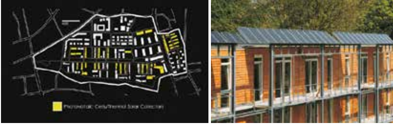
Şekil 17. Vauban güneş kolektörleri(Fraker, 2013)..
