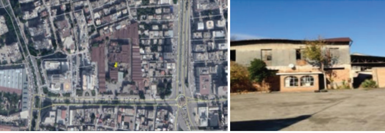
Resim 12. Alman Fabrikası (Arcı, 2019)
