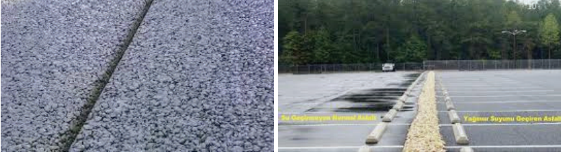
Şekil 8. Geçirimli yüzey örnekleri (URL-2).
