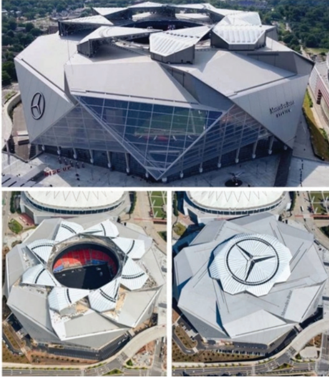
Şekil 5. 3 Stadyum çatısının açık ve kapalı hali (Url-15)
