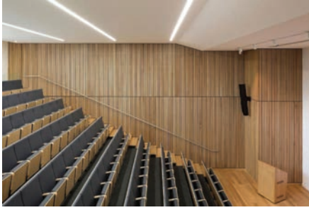
Şekil 10. Boşluklu rezonatör olarak ahşap latanın kullanılması (Url-1)
