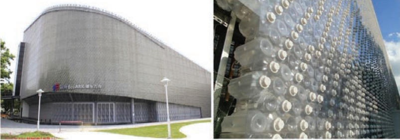
Şekil 3. 5 Cephesi plastik şişeden oluşan EcoArk projesi (Url-6)
