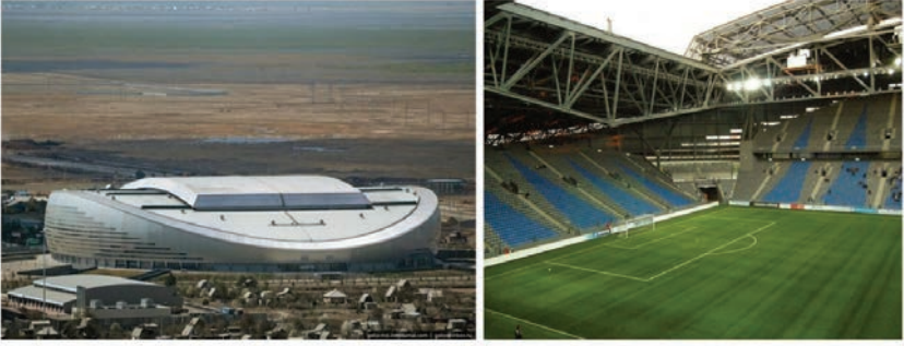
Şekil 4. 1 Hareket eden çelik malzeme çatı-Astana Stadyumu 2009 (Url-9)
