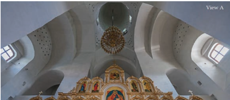
Şekil 12. Theophany Kilisesi, Pskov boşluklu rezonatör kullanımı (Kanev, 2020)
