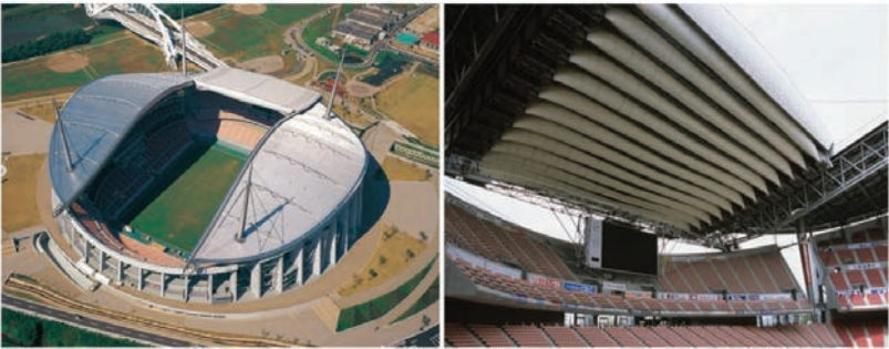
Şekil 4.2 Hareket eden PVC malzeme çatı- Toyota Stadyumu 2001 (Url-10)
