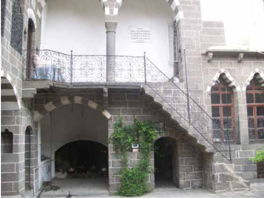
Resim 1. Esmâ Ocak evi hamam mekanı girişi
