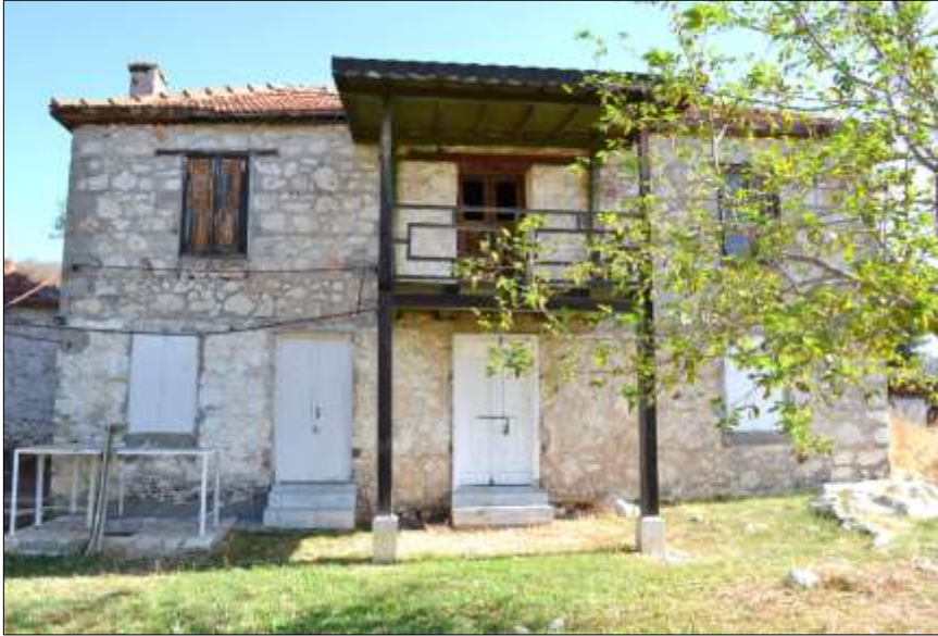
Şekil 6. Eski köy evi ana yapı (Aybike Yenel Kişisel Arşivi, 2019)
