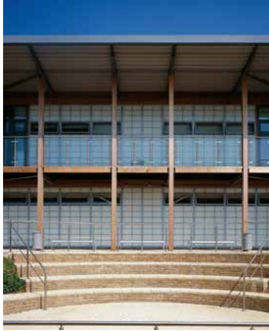
Şekil 8: High Crest Okulu ek binasında (Londra, İngiltere) yarı-Saydam aerojel paneller ile cephe kaplaması uygulaması (URL-6)
