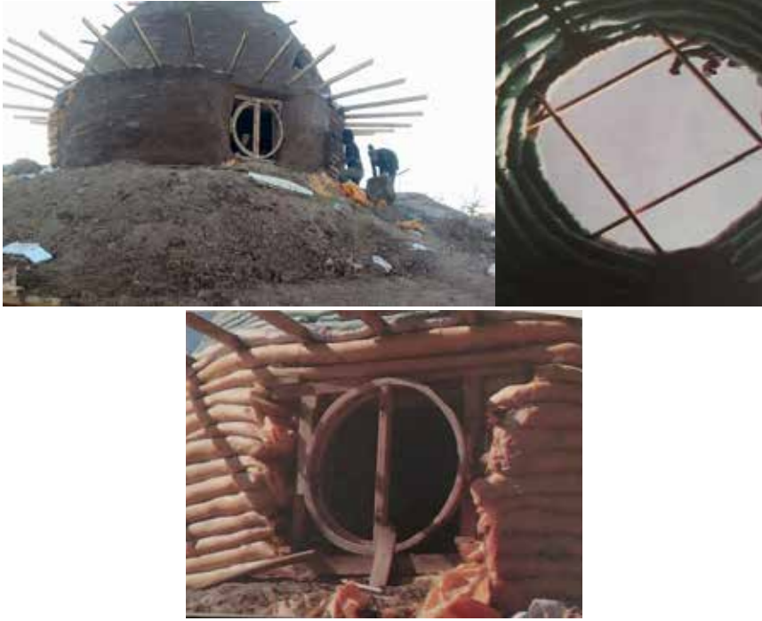
Şekil 2. Eko-dam uyarlaması (earthbag) (Rusipi,2018)
