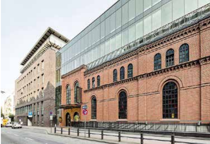
Şekil 5: East Hotel (Hamburg, Almanya) binasında fotokatalitik kendini temizleyen özellikte cam uygulaması (Leydecker, 2008; URL-5)
