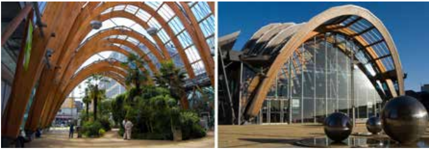
Şekil 4: The Winter Garden (Sheffield, İngiltere) yapısında ahşap malzemede renk değişimi (URL-3; URL-4)
