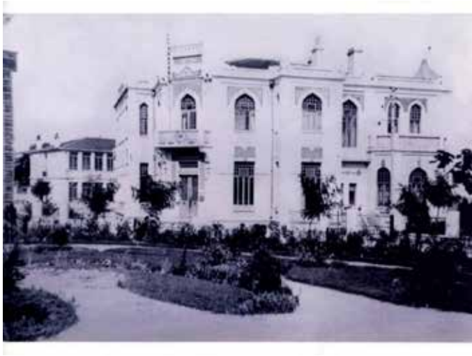
Fotoğraf 12: Batı Cephesi- 1929 (Müze arşivi).
