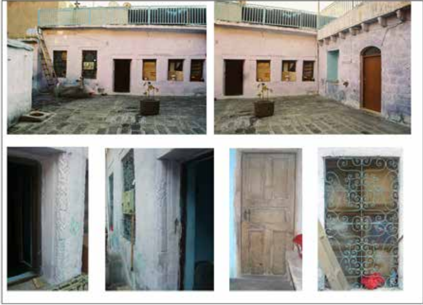
Resim 5. Sait Paşa Konağının müştemilat bölümü
