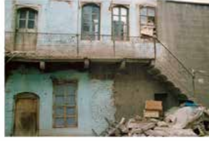
Resim 8. Selamlık batı cephesi (Sargöl 1992)
