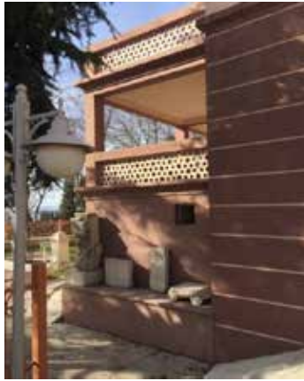
Fotoğraf 21: Projede Belirtilen Yangın Merdiveni Yeri (Şar, 2020).
