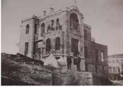
Fotoğraf 10: Yapı İnşaat Aşaması. Güneybatı Cephe-1928 (Müze Arşivi).
