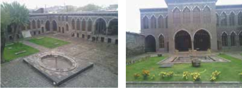
Şekil 28. Cemilpaşa konağı selamlık kısmında (elips) haremlik kısmında (dikdörtgen) havuz örneği
