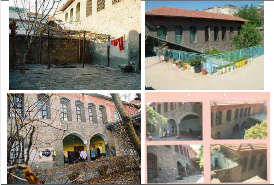
Resim 4. Sait Paşa Konağına haremlik bölümü
