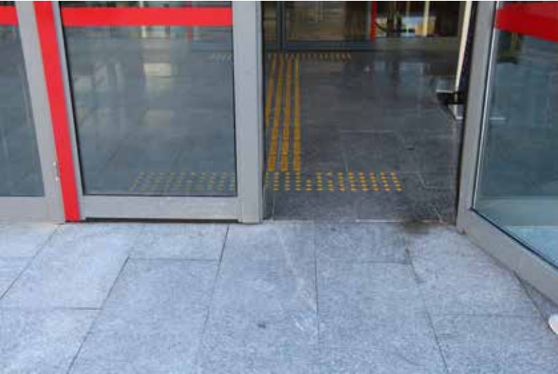
Şekil 2.10.3: Bina Giriş Kapısının Dış Kısmına Yapılmayan Yüzey İşaretleme
