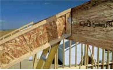
Şekil 13.c. PSL ahşap elemanın çatı kirişi olarak kullanımı (URL-15, 2017)
