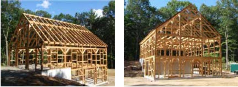
Şekil 28. Ahşap dikme-kiriş sistemi ile üretilmiş ve eğime oturan bir yapı (URL-27, 2017)
