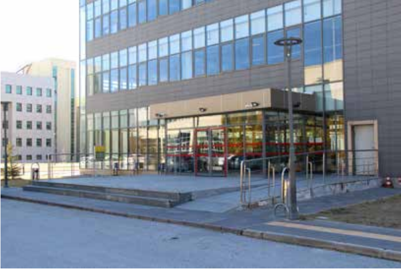
Şekil 2.1.1: Uşak Üniversitesi Prof. Dr. Fuat SEZGİN Kütüphane Binası Girişi
