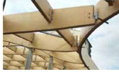
Şekil 15.d. LVL elemanın dekoratif üst örtü olarak kullanımı (URL-17, 2017)
