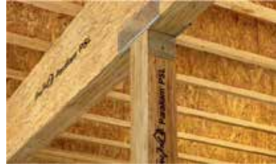
Şekil 13.d. PSL ahşap elemanın döşeme kirişi olarak kullanımı (URL-15, 2017)
