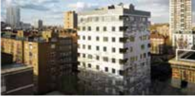
Şekil 21.a. Stadthaus binası tamamlanmış görünümü (KLH, 2009)
