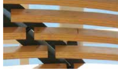
Şekil 15.b. LVL elemanın kiriş elemanı olarak kullanımı (URL-17, 2017)
