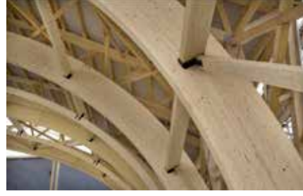
Şekil 16.b. GLULAM elemanlar ile bir spor salonunun çatısı (URL-18, 2017)
