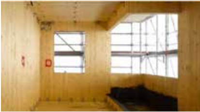
Şekil 21.c. CLT panellerin bitirme işlemlerinden önceki durumu (KLH, 2009)
