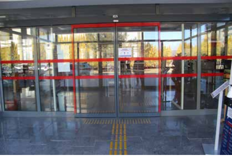
Şekil 2.4.1: Ana Girişin İç Kısmında Bulunan Otomatik (Fotoselli) Kapı
