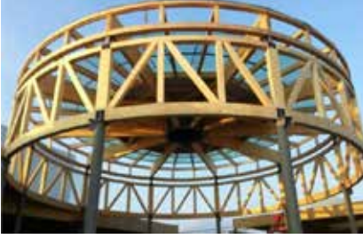
Şekil 18.a. GLULAM farklı formlarda kirişler ile yapılan farklı bir üst örtü (URL-20, 2017)
