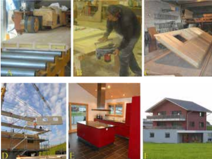
Şekil 37. Boşluklu ahşap panellerin fabrika ortamından konut üretimine kadar kullanım evreleri (Hausammann & Franke, 2014)
