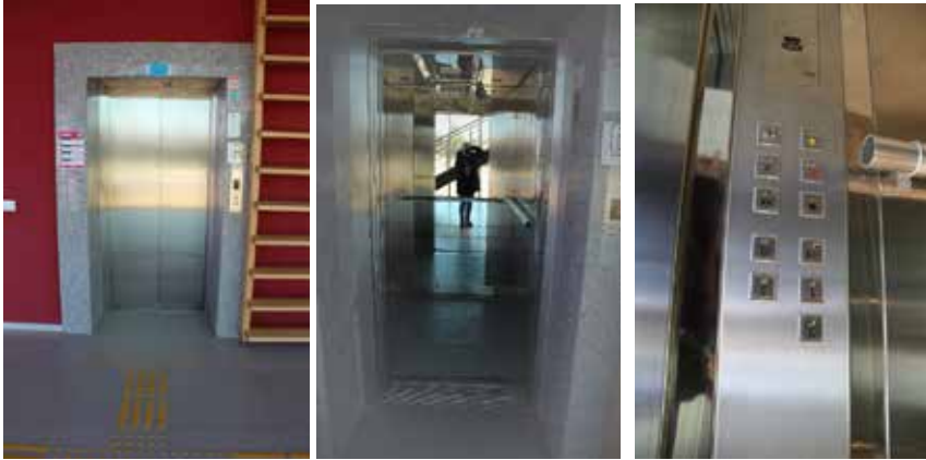
Şekil 2.6.3: Mevcut Asansör ve Paneli
