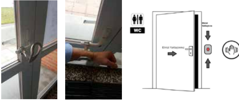
Şekil 5. Solda; Direkt el temasını azaltan kapı ve pencere uygulamaları (Maranha vd., 2021) , Sağda; El sensörlü otomatik kapı uygulaması (URL 2)
