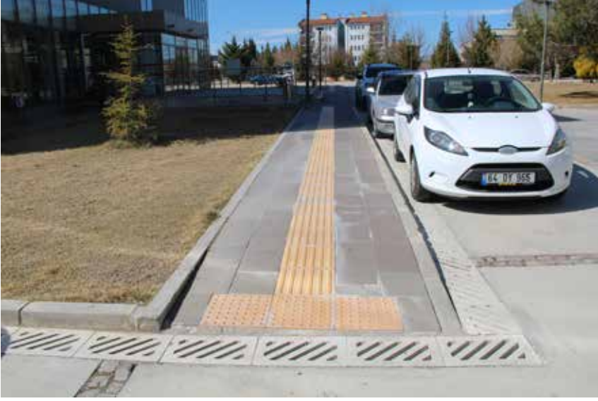
Şekil 2.1.2: Kütüphane Binası Çevresi Yaya Kaldırımı ve Drenaj Kapakları
