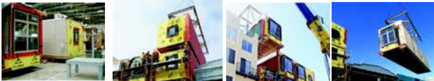
Şekil 44. Ahşap malzeme kullanılarak modüler sistem konut uygulaması (WoodWorks, 2014)
