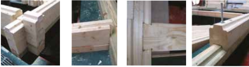
Şekil 27.a. Yığma sistemde kütük elemanların bağlantı detayları (Branco ve diğer., 2013)
