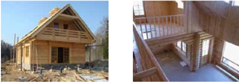
Şekil 27.b. Yığma (kütük) ev örnekleri-yapım sırasında (URL-26, 2017)
