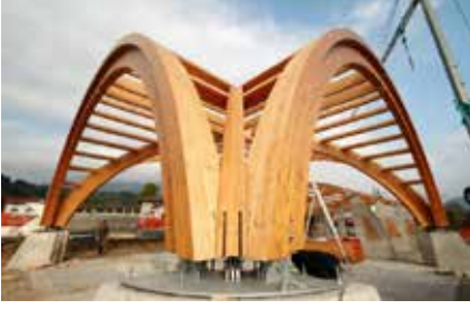
Şekil 16.a. GLULAM elemanlar ile bir dış mekân üst örtüsü (URL-18, 2017)
