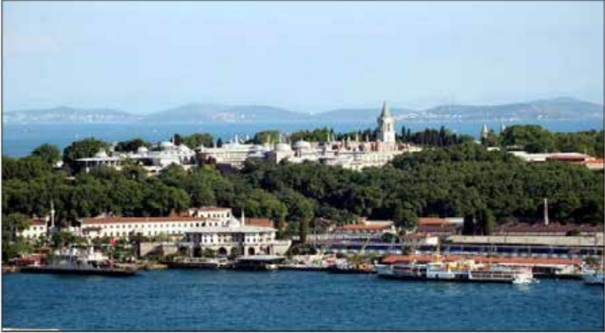
Şekil 1. Topkapı Sarayı genel görünüm (Anonim,2021).
