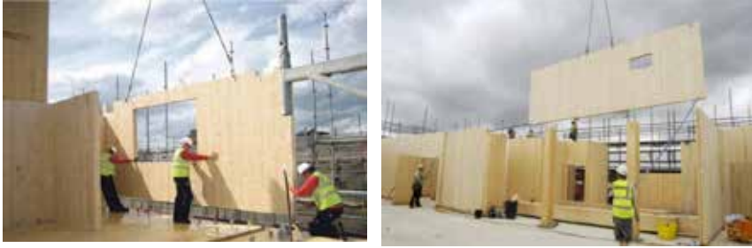
Şekil 40. Tabaklı ahşap panellerin şantiye sahasında montajı (URL-32, 2017)
