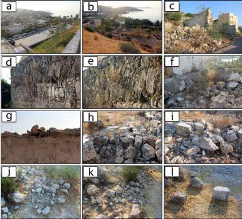
Figür 7. Anıtın karşı karşıya kaldığı çevresel tehditler; a, b, c) anıt çevresinde bulunan turizm tesisleri, d, e) anıt duvarlarında gelişen bitkiler ve çalı formundaki ağaççıklar, f) anıtın çöken kesimlerinde gelişen tek yıllık otsu bitkiler, g) yapı tonozunun ayakta kalan kesimlerinde gözlenen harç çözünüşleri ve yapı taşı ayrışmaları, h, i) anıtın çökmüş kesimlerindeki yapı elemanlarının bozulan sıralamaları, j, k, l) anıtın taş malzemelerinin alınması.
