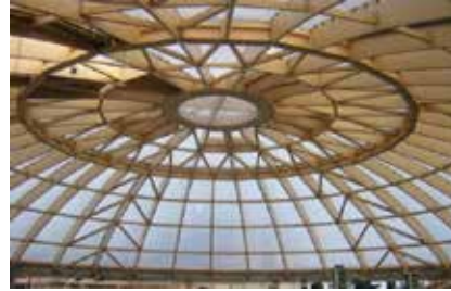
Şekil 17.b. GLULAM elemanlar ile kubbe formunda üst örtü (URL-19, 2017)
