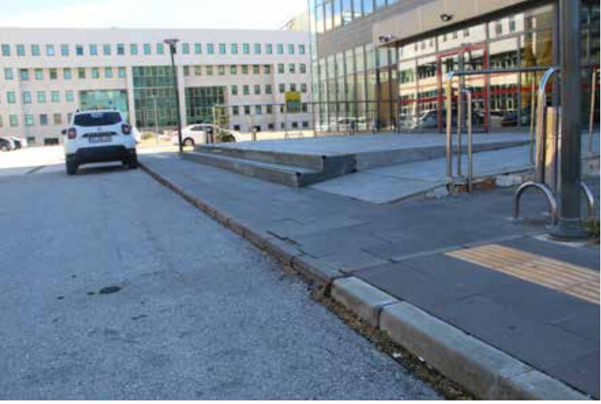
Şekil 2.10.2: Merdivenlerde Kesintiye Uğrayan Yüzey İşaretleme
