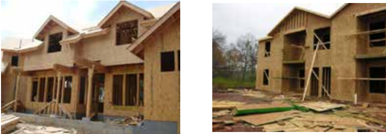
Şekil 11. OSB levha ile konut üretim örnekleri (URL-11, 2017)
