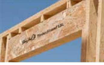
Şekil 14.a. LSL kirişlerin yapıda kullanımı (URL-16, 2017)
