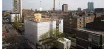
Şekil 21.b. Stadthaus binası yapım sırasında CLT panellerin kullanımı (KLH, 2009)
