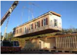
Şekil 42. Modüler yapım sistemiyle üretilen konut birimlerinin yerleştirilmesi (URL-34, 2017)
