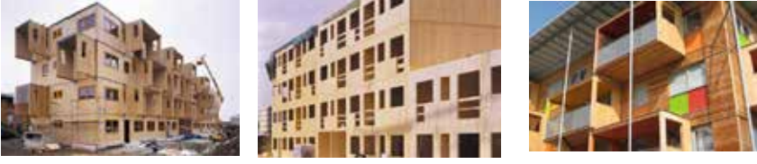
Şekil 20. Avusturya'da CLT panel çok katlı konut uygulaması (Karacabeyli & Douglas, 2013)
