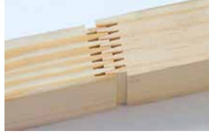
Şekil 18.b. GLULAM elemanların birleşim yöntemi 'finger joint' (URL-20, 2017)
