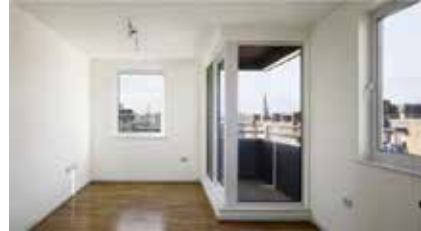
Şekil 21.d. Bitirme işlemleri sonunda iç mekânın durumu (KLH, 2009)
