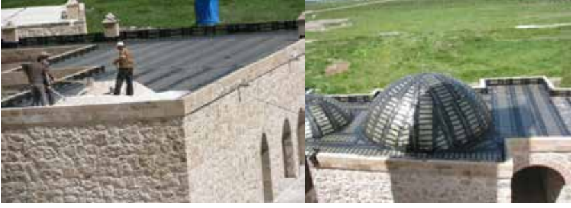
Şekil 58,59. Medrese Örtü İzolasyon Yapım Görünüşleri (Ş. Öztürk)
