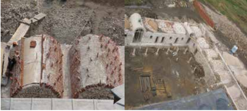
Şekil 54,55. Medrese Tonoz-Kubbe İnşa Görünüşleri (Ş. Öztürk)
