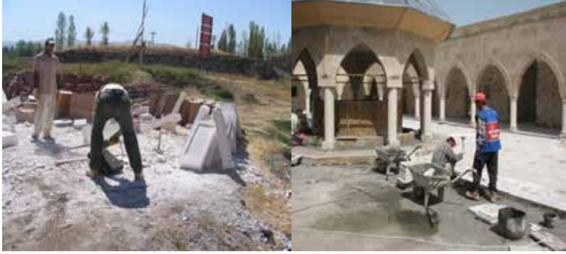
Şekil 44,45. Medrese Malzeme ve Zemin Kaplama Yapım Görünüşleri (Ş. Öztürk)
