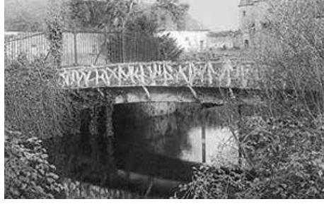
Şekil 3 İlk donatılı köprü (Betonarme),Chazelet, Fransa, Joseph Monier,1875
