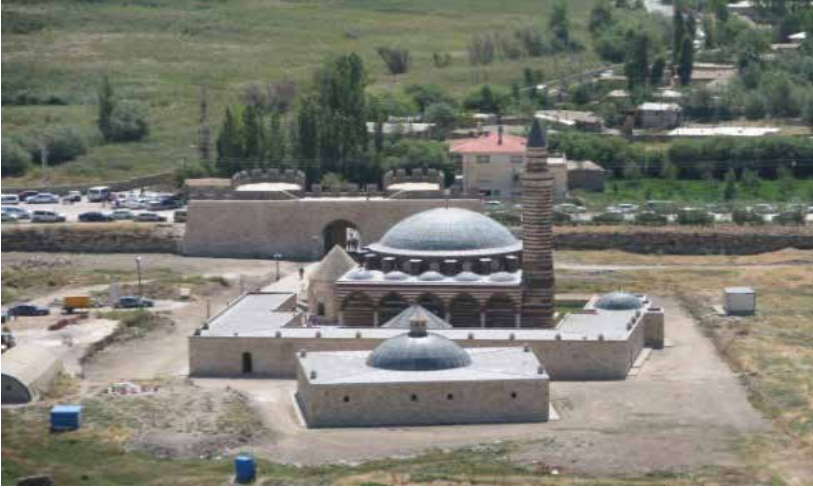
Şekil 31. H.P.K. Kuzey Onarım Sonrası Genel Görünüşü (Ş. Öztürk)
