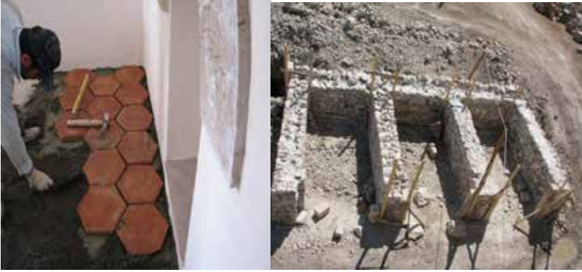
Şekil 42,43. Medrese Tuğla Kaplama ve Duvar Yapım Görünüşleri (Ş. Öztürk)
