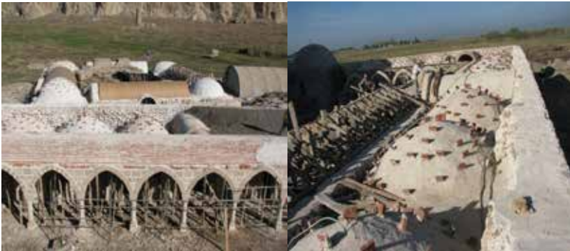
Şekil 56,57. Medrese Tonoz-Kubbe İnşa Görünüşleri (Ş. Öztürk)
