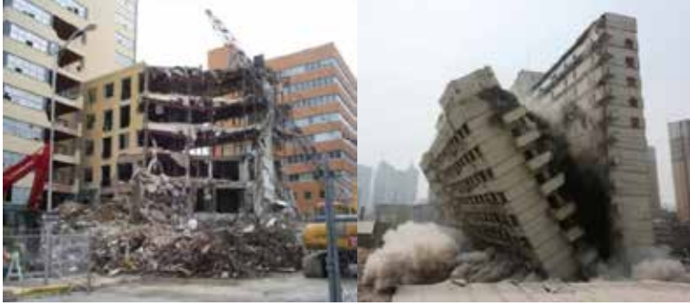
Şekil 1. Uyarlanabilir detaylara sahip olmayan yapıların yıkım süreçleri [Url-1, Url-2]
