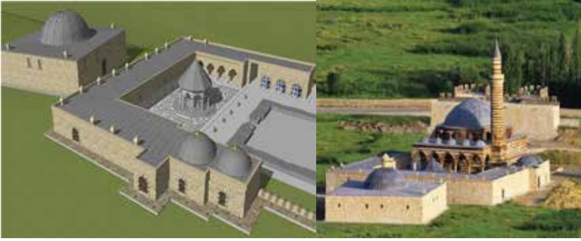
Şekil 60,61. Onarım Sonrası Genel Görünüşleri (Ş. Öztürk)
