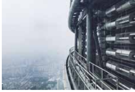
Resim 19. Kulenin bitiş parapetine yerleştirilen rüzgâr tribünleri [URL29]
