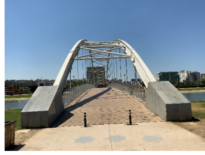
Şekil 3.2.8 Yaya köprüsü (Merve ŞİMŞEK, 2023-Orijinal)
