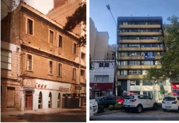
Resim 3-4. Yapının II. Kordon cephesinin geçmişteki ve günümüzdeki görünümü
