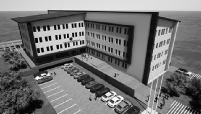
Şekil 27: Hınıs Adliye Hizmet Binası Değerlendirilen 3. Seçenek (Çatı eğimleri yaya hareketinin olmadığı yöne kaydırılmıştır)
