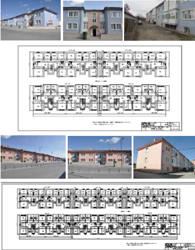
Şekil 11. İstasyon Caddesi'nin güney hattını tutan lojmanlar (Sivas KTVKK; Tüdemtaş Arşivi, 2018).
