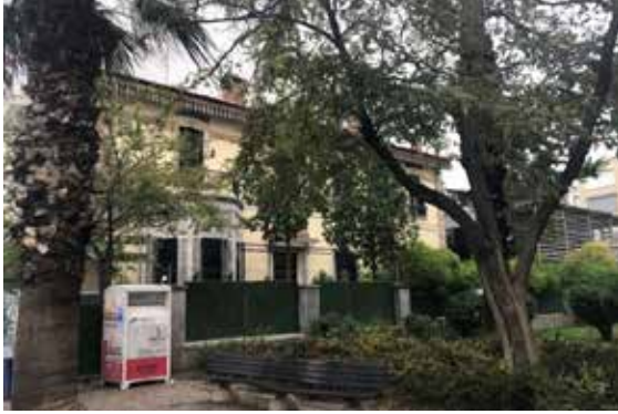
Resim 11. Köşkün bahçesine yapılan çağdaş ek
