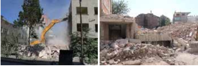
Şekil 6. Sahabiye Kentsel Dönüşüm Projesi'nin yıkım aşamasına dair fotoğraflar. (Sönmez arşivi, 2017)
