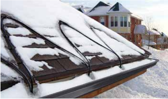
Şekil 5: Buz Barajlarını Önlemek İçin Uygulanan Isıtıcı Kablo ("Model SRP," 2019)
