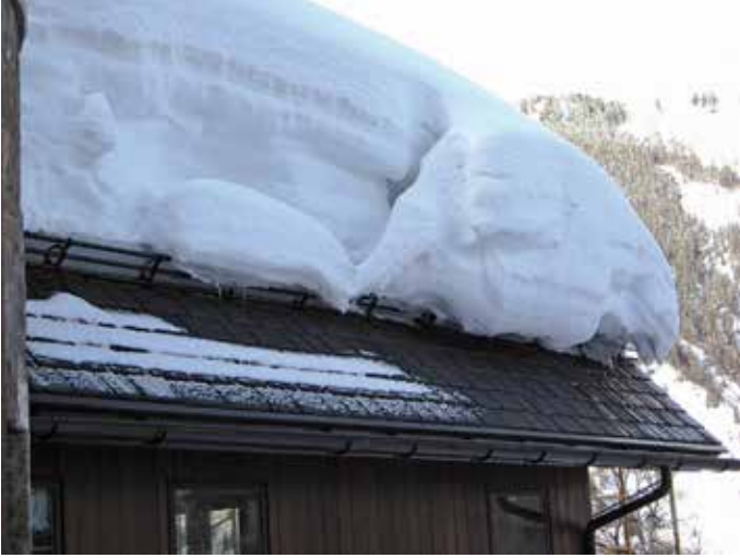
Şekil 11: Çatıda Biriken Karın Düşmesini Engelleyen Kar Tutucu ("Snow Guard," 2019)
