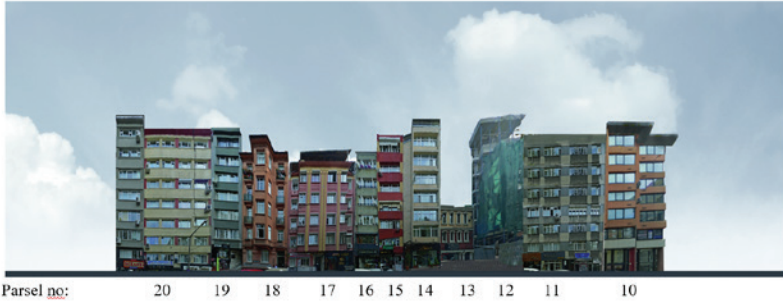
Şekil 8: Abide-i Hürriyet Caddesi parsel 10-20 arası mevcut görünüş
