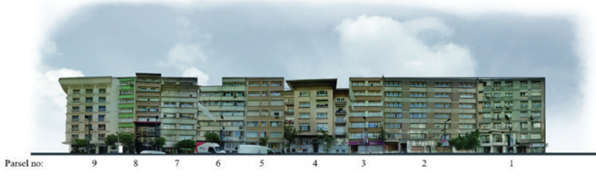
Şekil 6: Abide-i Hürriyet Caddesi parsel 1-9 arası mevcut görünüş
