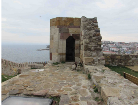
Resim 7 – Kale (Hüdâvendîgâr) Câmii'nden günümüze kalan platformu ile minare kaidesi (Kahraman, 2017)
