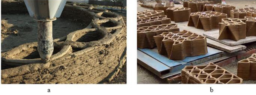
Şekil 5. 2 : a. İtalya'da teknoloji köyü, 12 metrelik yazıcı ile kerpiç yapı üretimi (Wasp, 2016).
