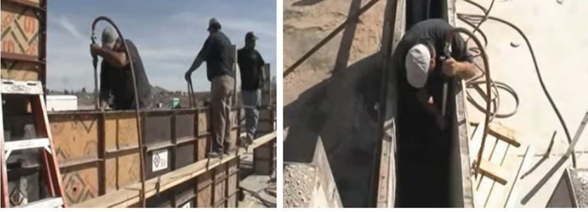
Şekil 5. 1 : Mekanik yöntem ile sıkıştırılmış toprak üretimi (URL- 4).
