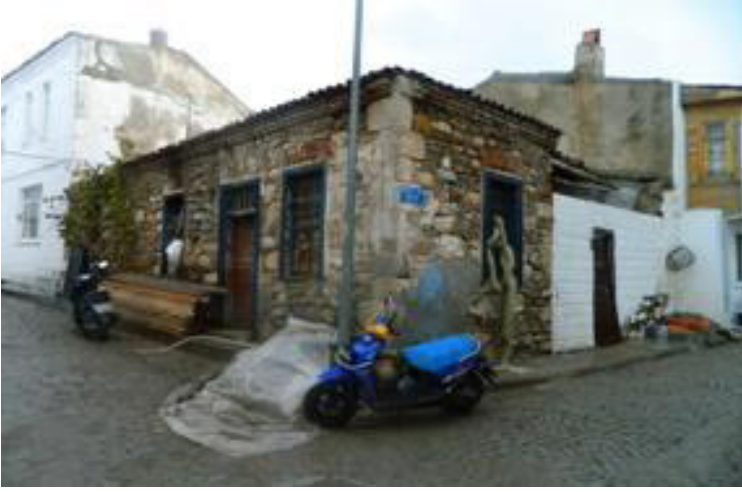
Resim 14 – Bozcaada'da moloz taş ve yontu taş malzemeli kagir konut (Kahraman, 2017)
