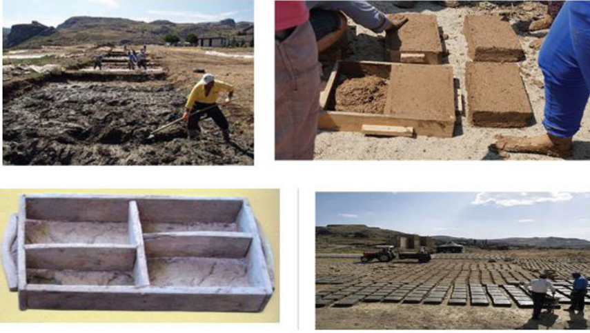
Şekil 3.3 : Kerpiç yapım aşamaları (Çavuş, M., Ulusu, H., Aruntaş, H. Y., 2015).
