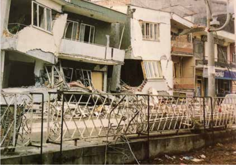
Resim 4 Bina Hasarları (Çuhadaroğlu, F. ve diğerleri, 1992, s.50)
