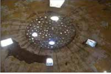
Şekil 28. Sıcaklık kubbesindeki fil gözleri ile pencereler
