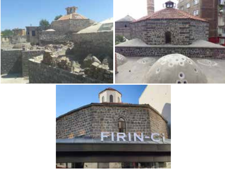
Çardaklı Hamamı (2020) Kadı Hamamı (2020) Vahap Ağa Hamamı (2020) Şekil 3. Diyarbakır Suriçi Bölgesindeki Hamam Örnekleri
