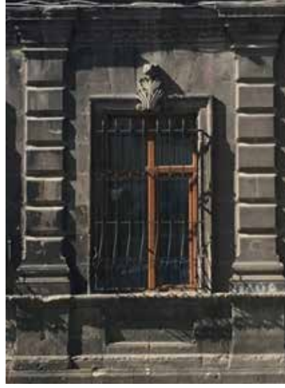
Resim 3.7 Ahşap pencere (Peker, 2020)
