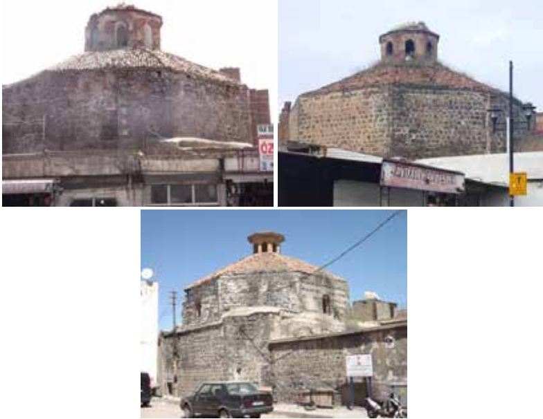
Melik Ahmet Paşa Hamamı (2020) Deva Hamamı Paşa Hamamı (2020) Paşa Hamamı (Saticı 2015)
