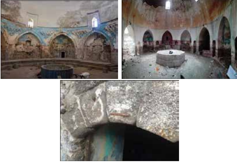
Şekil 26. Soğukluk ve sıcaklık bölümlerindeki kemer ve tonozlar
