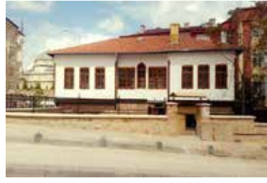
Kayyumzade Konağı (Url 5)
