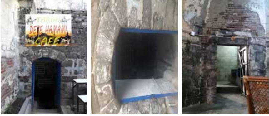
Şekil 6.Deva Hamamı Deve Hamamı Sokaktaki Kadınlar Girişi (2020)
