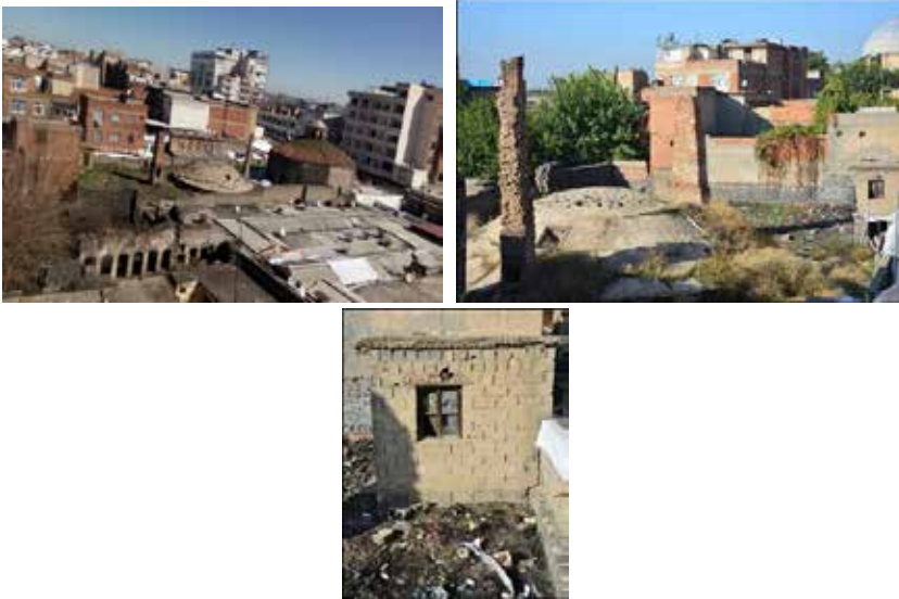
Şekil 25. Deva Hamamı üstünde toprak dolgu ve niteliksiz ekler
