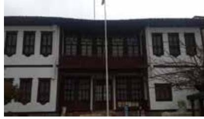
Nizamoğlu Konağı (Yozgat Müzesi)
